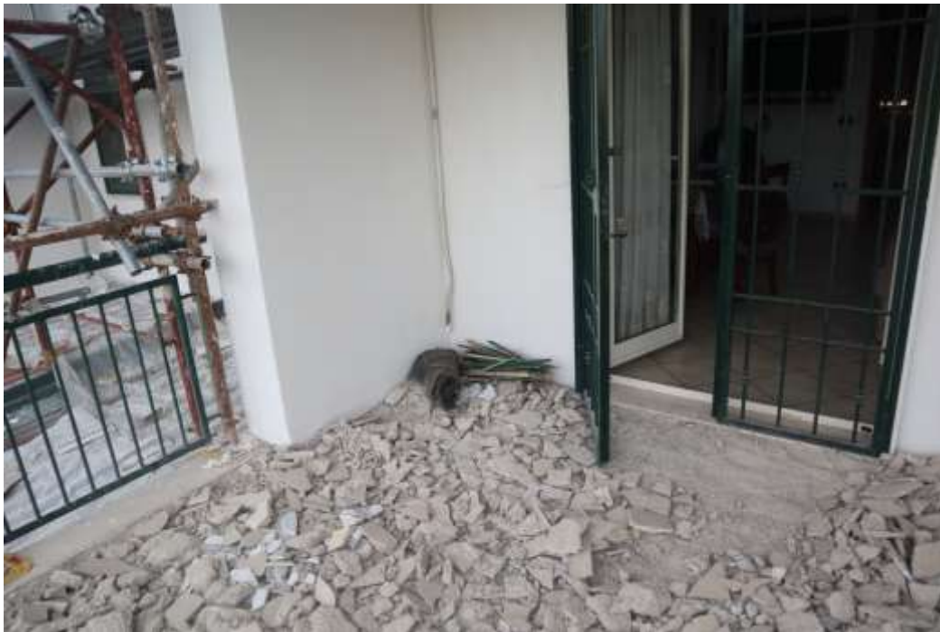
VISTA DEI LAVORI IN CORSO AI BALCONI AD OVEST
