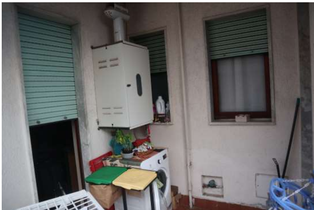
BALCONE LATO OVEST
