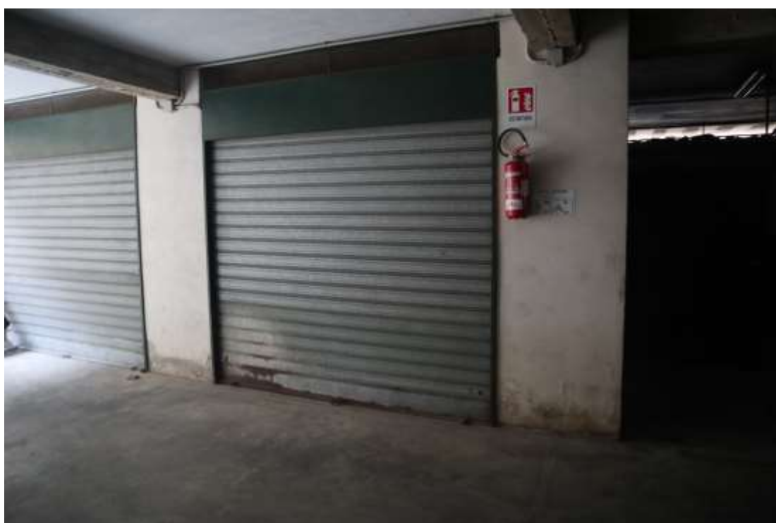
ALTRA VISTA ESTERNA DEL BOX
