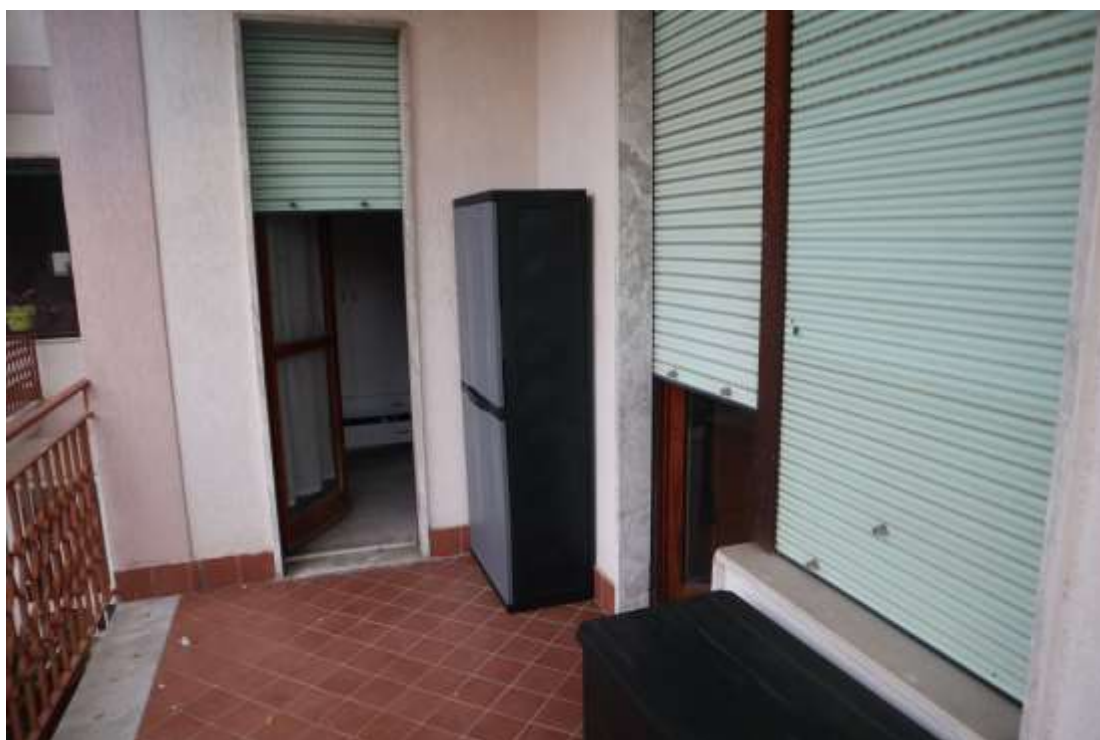
BALCONE LATO EST
