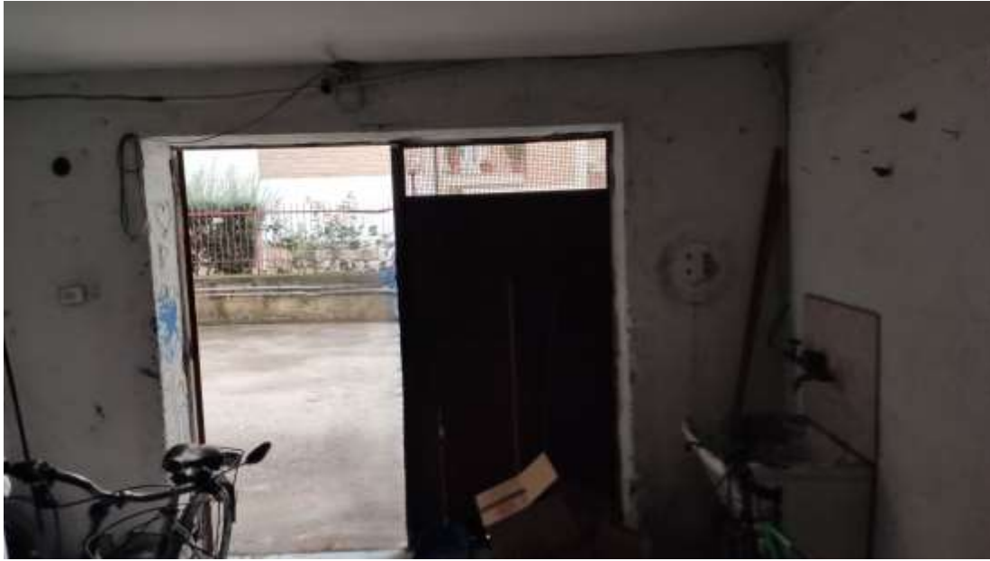
ALTRA VISTA INTERNA DEL BOX INTERNO 4
