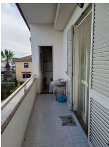
Balcone lato Nord
