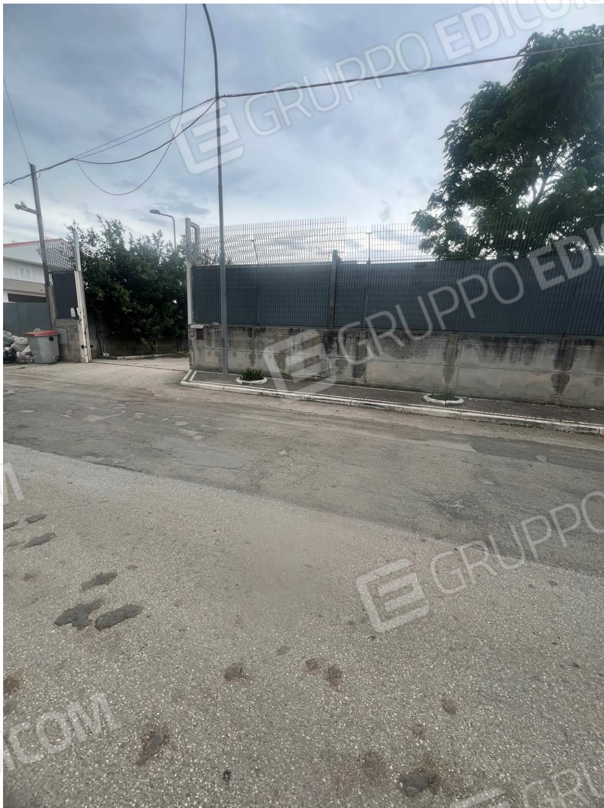
Ingresso via Via Nikita Sergeevic Kruscev
