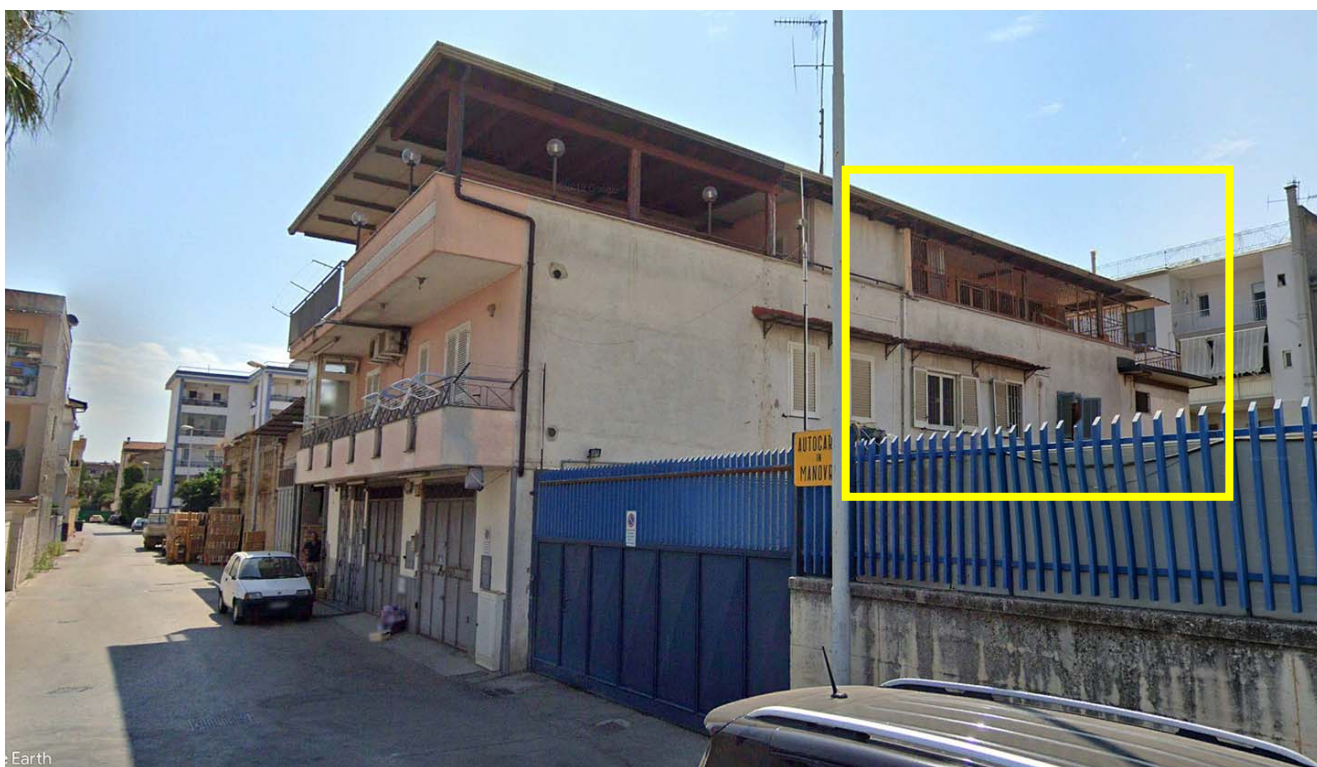
Foto 01. Fabbricato visto da via Giovanni Gentile
