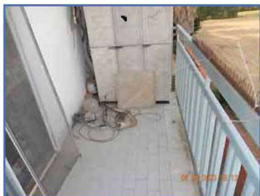
Immagine 10 – balcone lato Sud/Est
