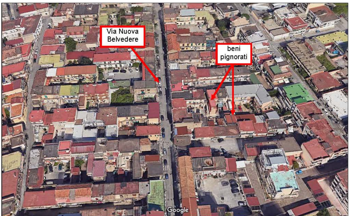
Vista satellitare dell'area oggetto di perizia
