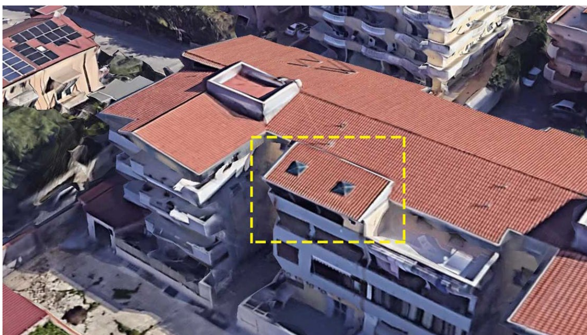
imm6.01: immagine aerea con indicazione della tettoia (estratto da Google Earth®)
