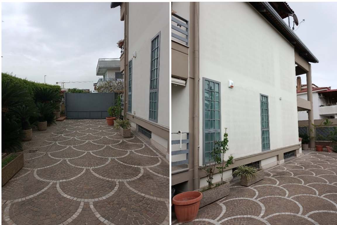
Foto 6. Foto 7. Esterni immobile, vista ulteriore ingresso carrabile giardino villino
