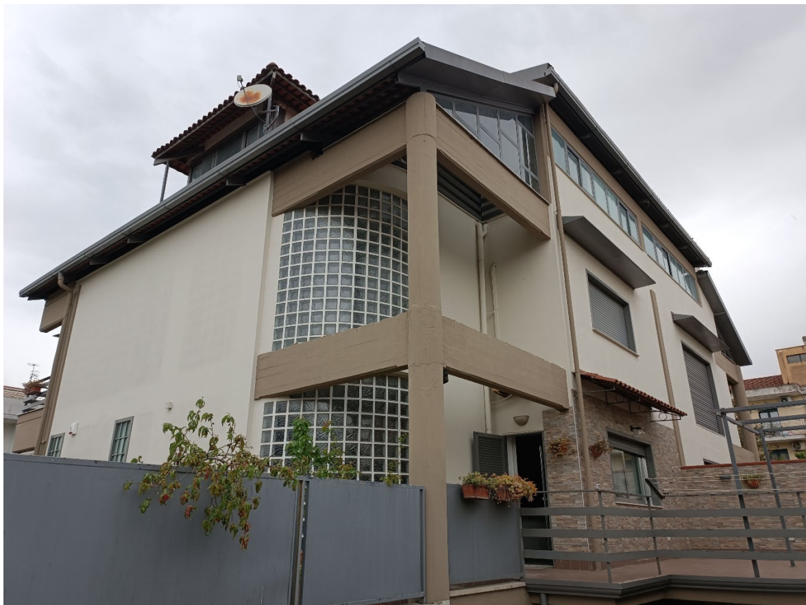
Foto 1. Foto 2. Esterni immobile
