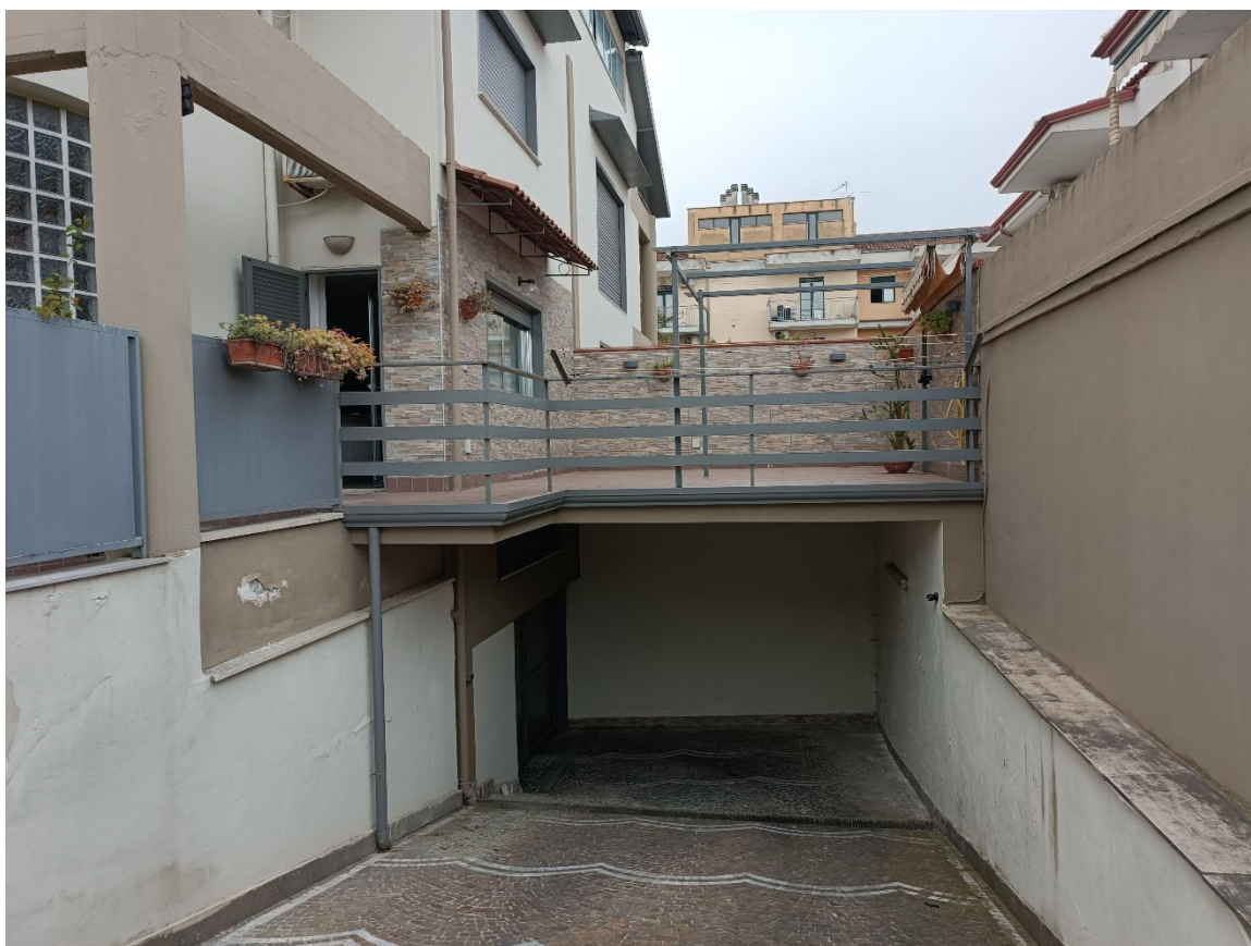
Foto 8. Esterni immobile: vista della rampa che porta al piano cantinato, non oggetto di pignoramento
