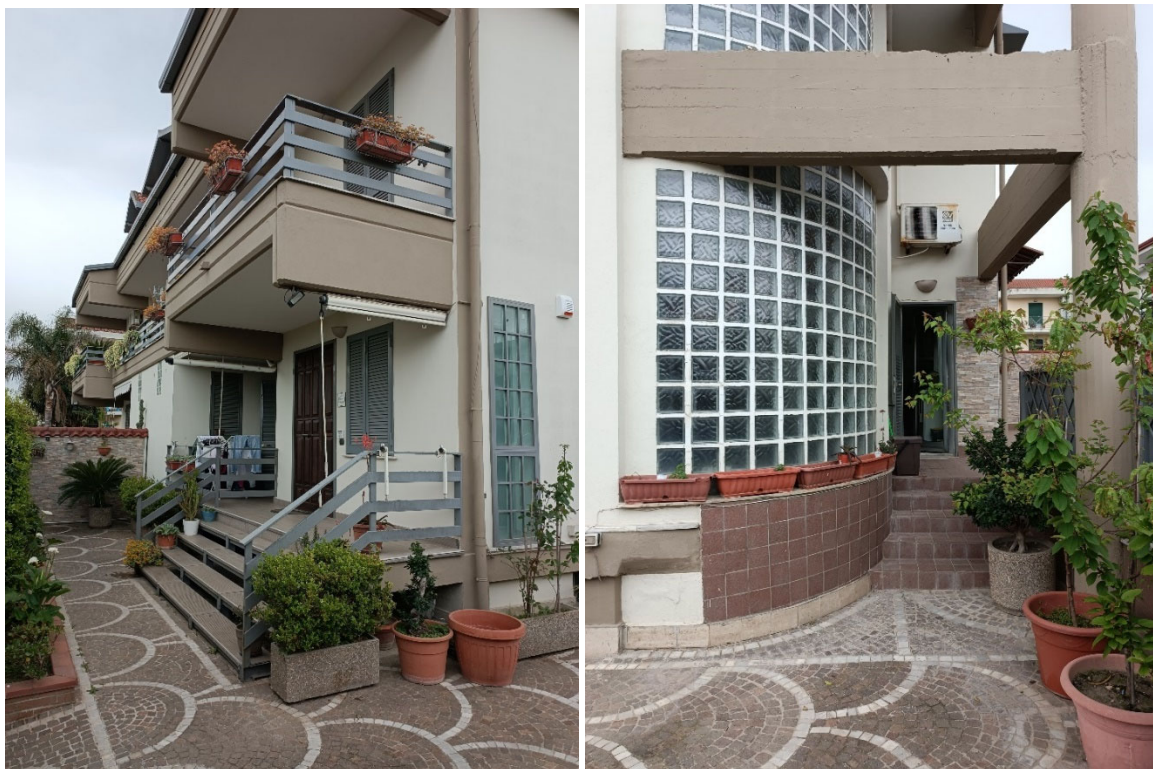
Foto 3. Foto 4. Esterni immobile
