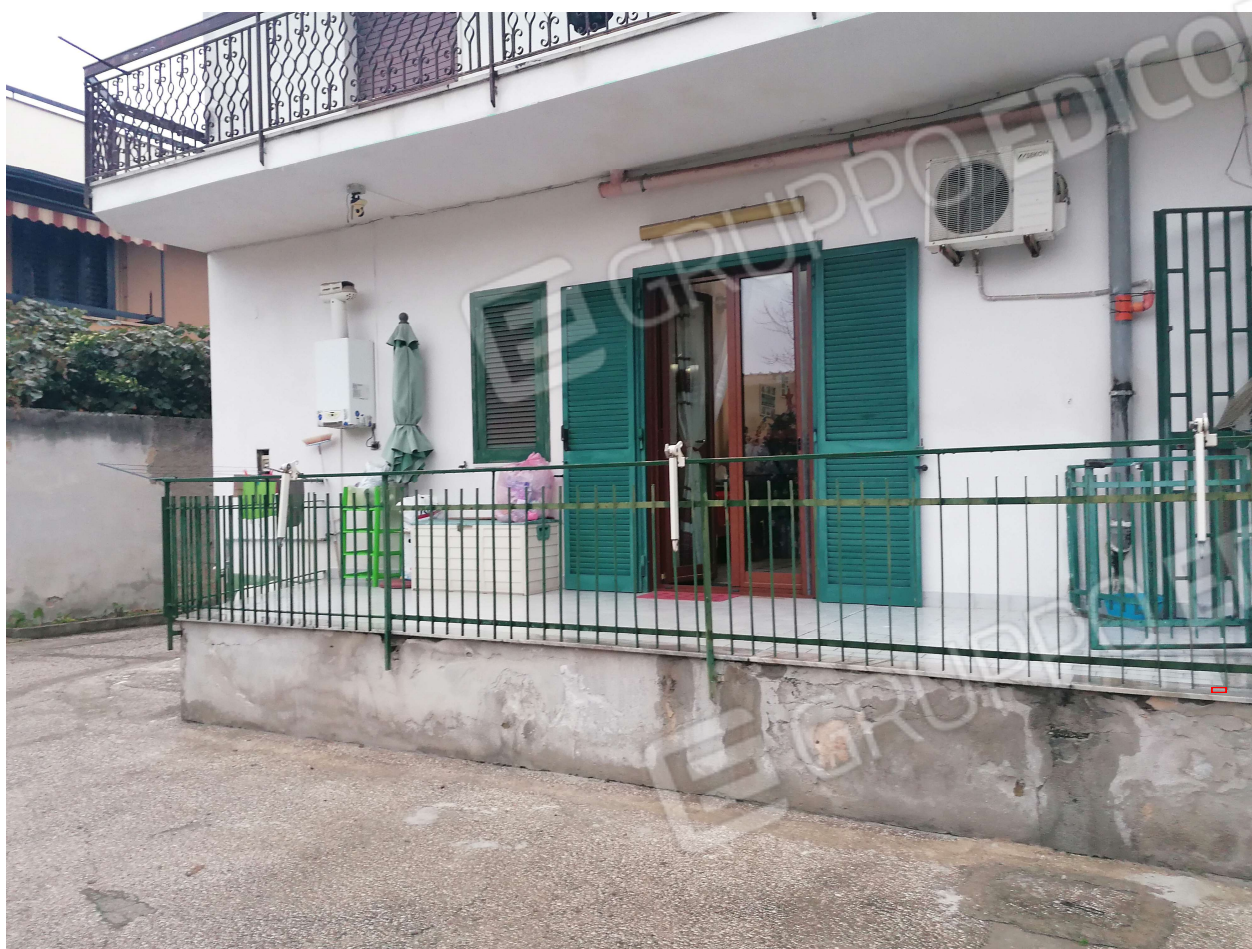
FOTO 3 – prospetto dalla corte interna
