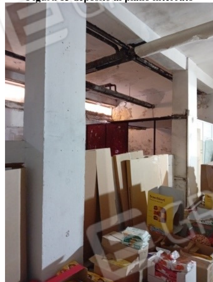
Figura 15 deposito al piano interrato
