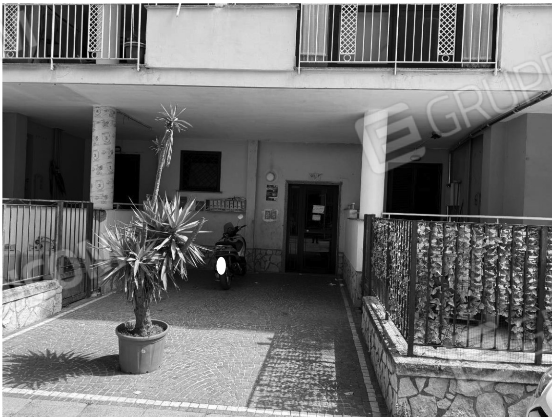
Foto 04 – L'ingresso alla scala F
