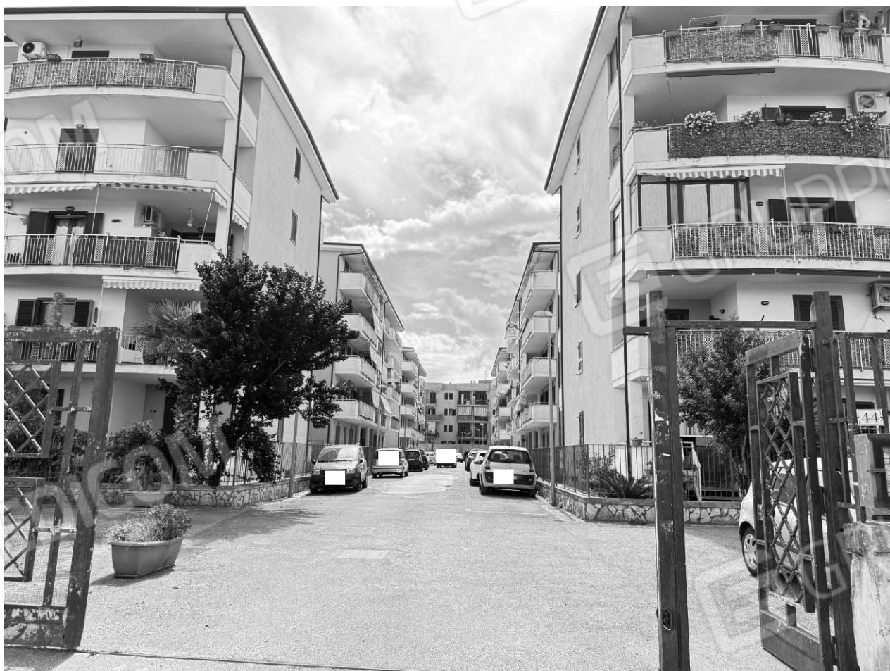
Foto 02 – Il viale interno al complesso immobiliare
