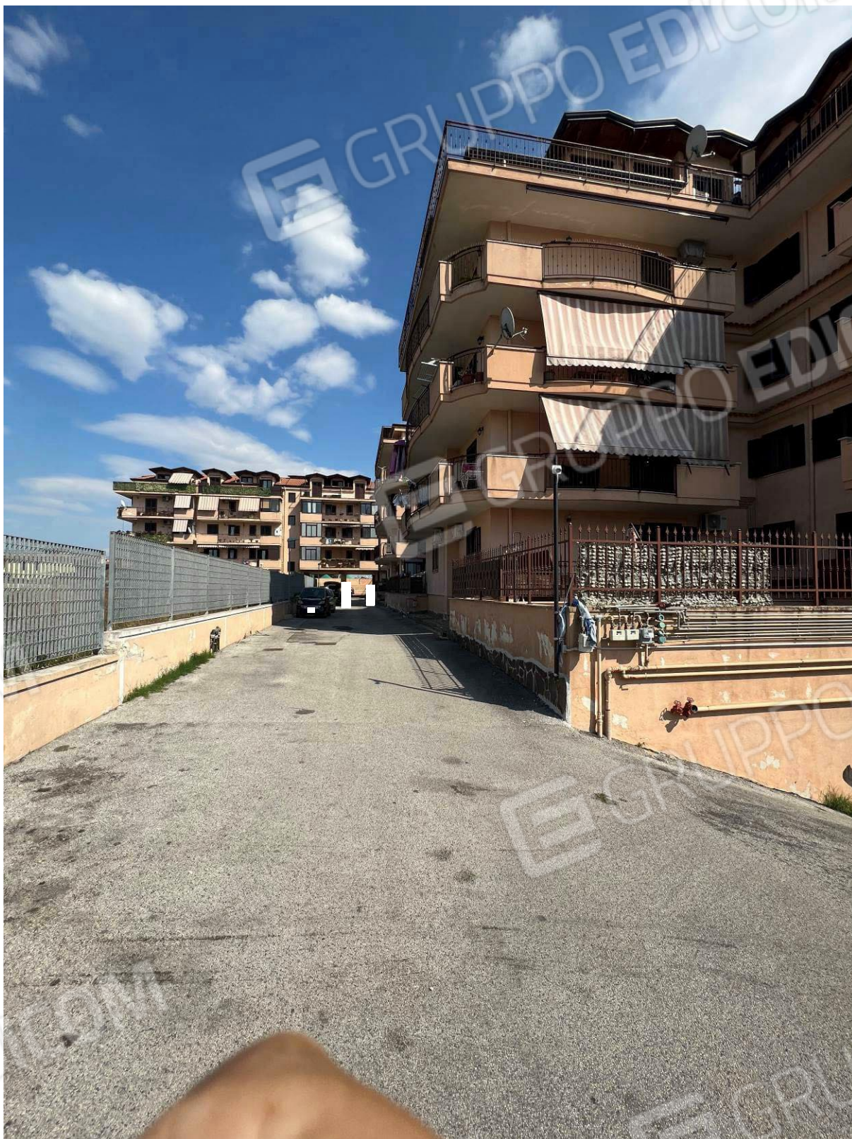
Foto Viale di accesso
