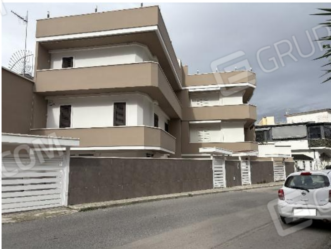
Fotografia n. 2 _ Prospetto su via Napoli, vista sud/nord
