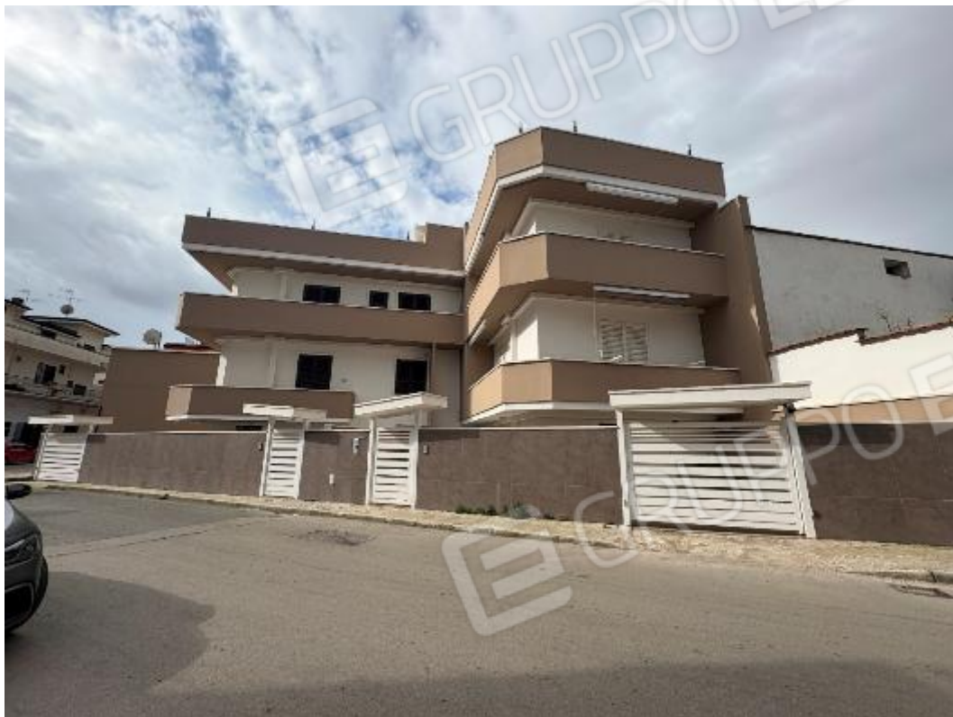
Fotografia n. 1 _ Prospetto su via Napoli, vista nord/sud
