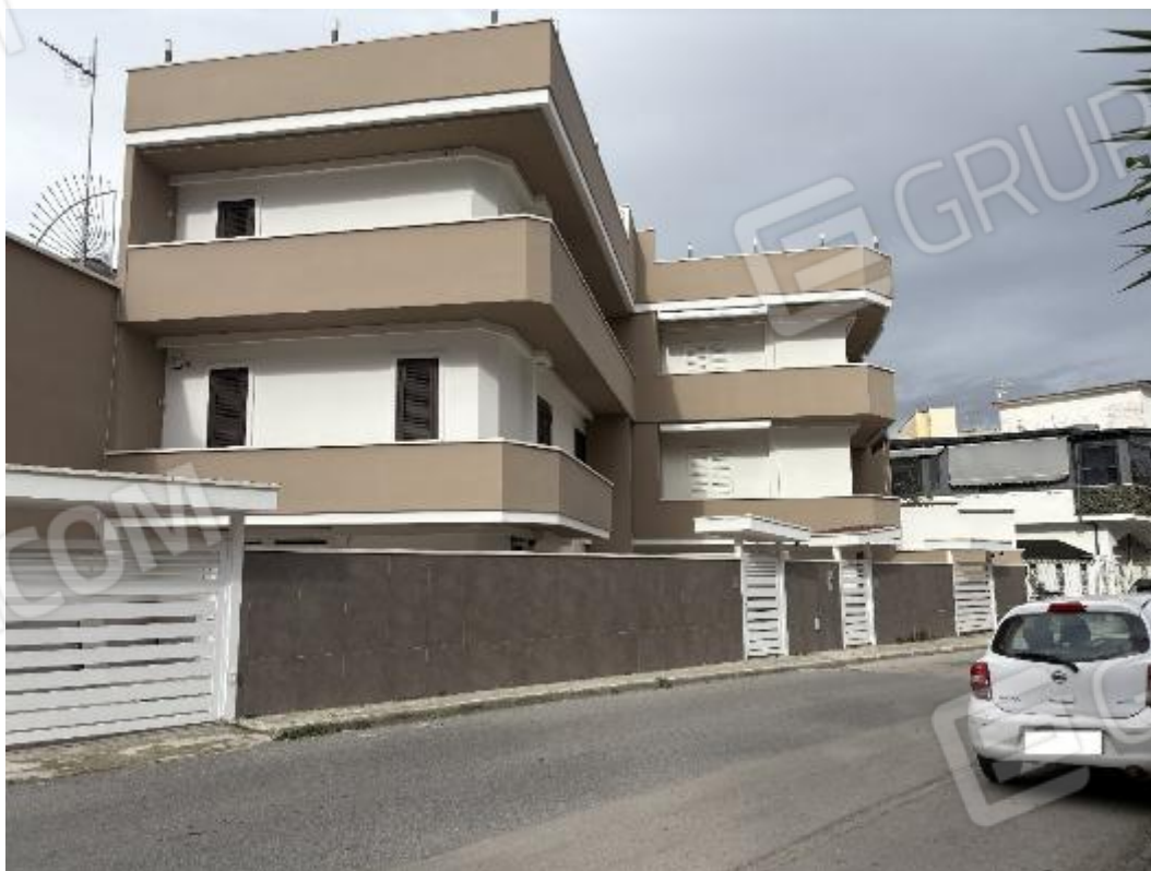
Fotografia n. 2 _ Prospetto su via Napoli, vista sud/nord
