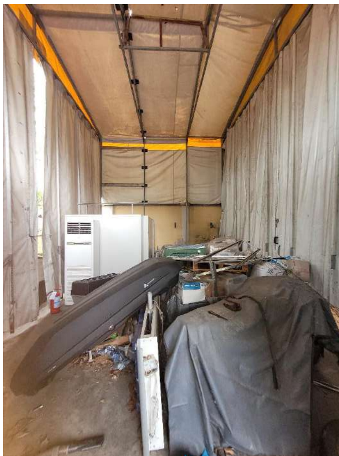
FOTO 44 – interno tensostruttura dove non sono state realizzate CELLE/DEPOSITI
