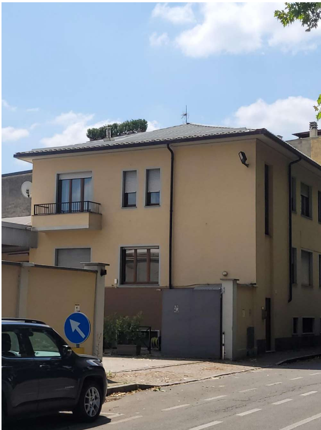
FOTO 3 – palazzina con particolare riferimento alla copertura- in lamiera grecata - in difformità al titolo originario
