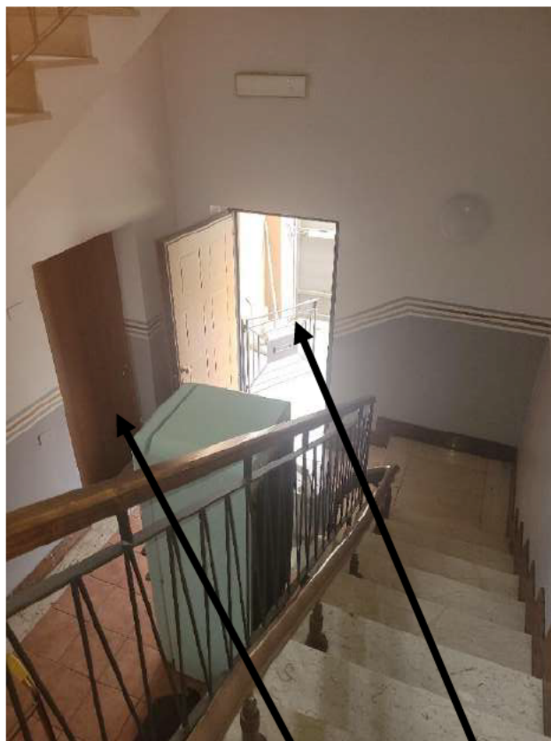
FOTO 4 – vano scala – ingresso strada e ingresso cortile
