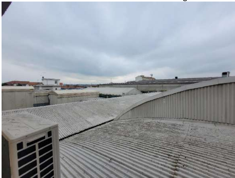
FOTO 5 – vista delle coperture
