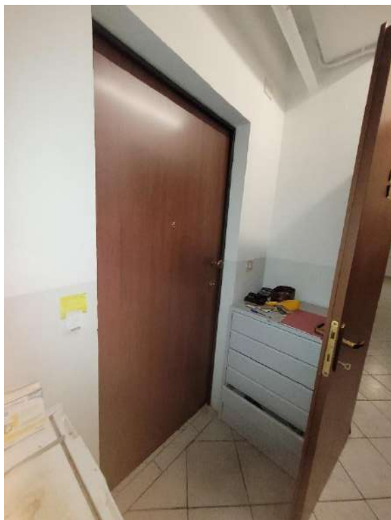
FOTO 37 – disimpegno (porta vano chiuso)
