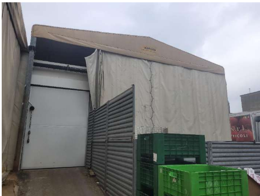
FOTO 42 – dettaglio zona di carico _realizzata sotto alla tensostruttura
