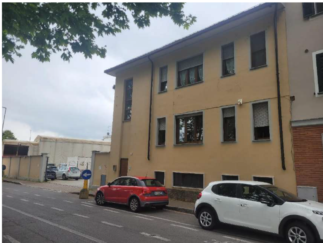
FOTO 2 FOTO 1 – vista della palazzina da Sud -Ovest
