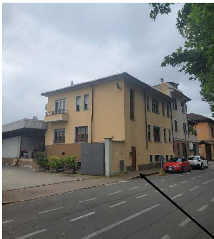
FOTO 1 – vista della palazzina da Nord Ovest
