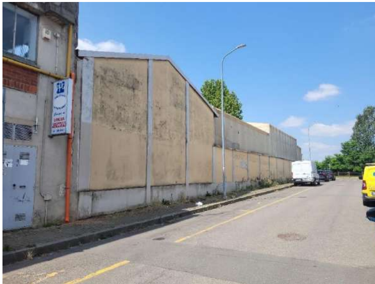
FOTO 4 - Vista del LOTTO da via Vinzaglio
