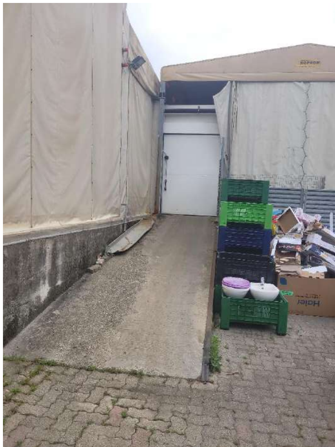
FOTO 41 – vista rampa di carico _ tensostruttura
