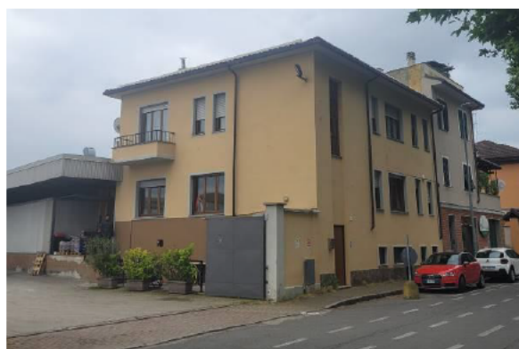
Foto stato attuale
