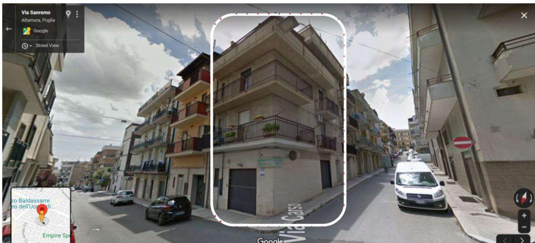
Secondo quanto riportato nella relazione tecnica allegata al progetto di completamento, la struttura portante del fabbricato è di tipo misto, costituita da telaio in c.a. interno e da muratura portante in tufo dall'esterno. I solai sono in latero cemento, le tompagnature in fo-
