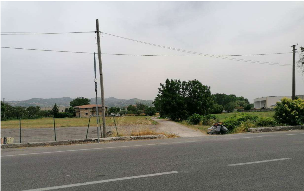
Figura 3: fotografia dell'area oggetto di ctu dalla viabilità comunale.
