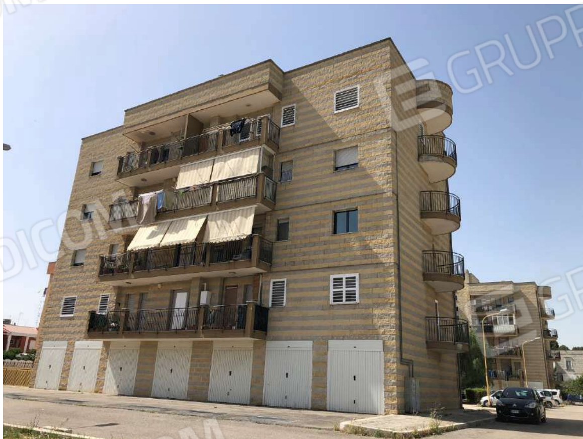
Foto n. 8 - Blocco C: prospetto retrostante e laterale
