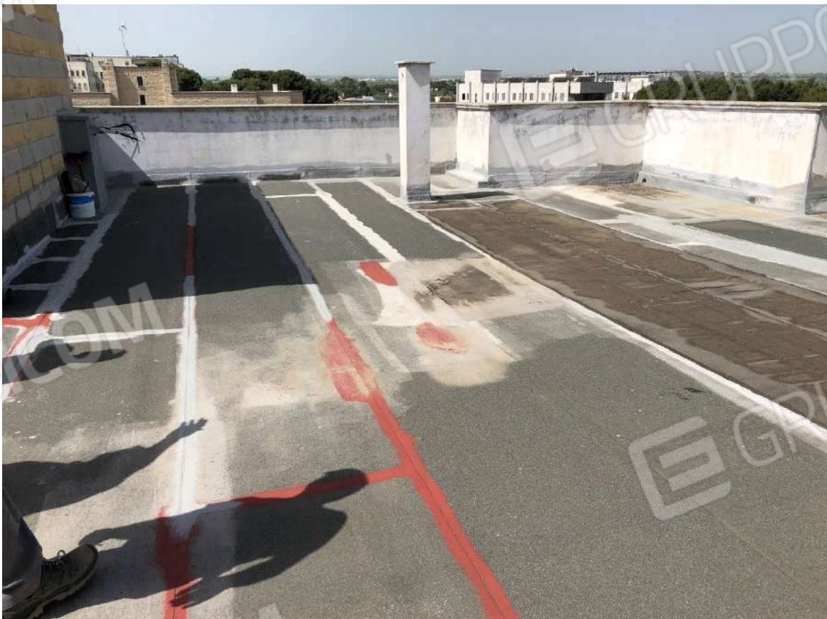
Foto n. 18 – I lastrici solari
