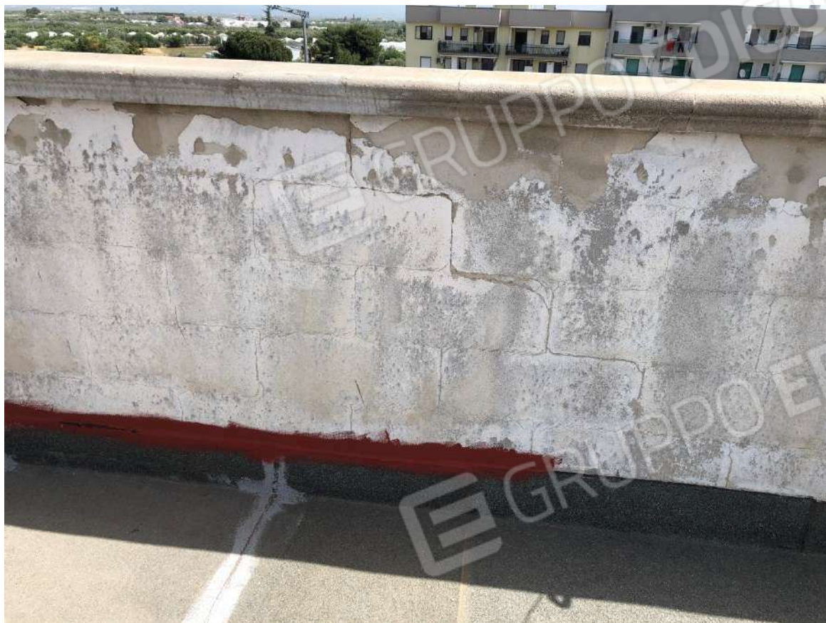
Foto n. 27 – I muretti d’attico
