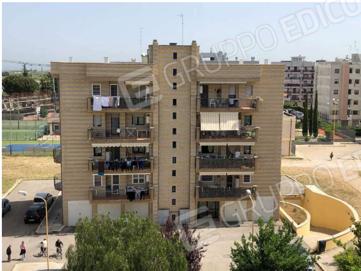
Foto n. 7 – Blocco C: prospetto principale su piazza Peppino Impastato
