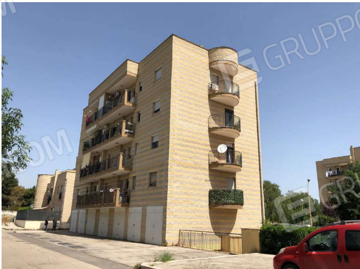
Foto n. 6 – Blocco B: prospetto retrostante e laterale
