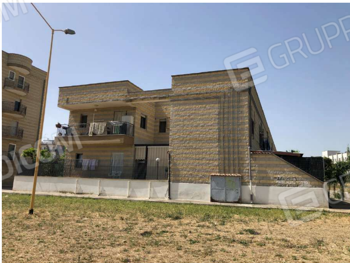
Foto n. 4 – Blocco A: prospetto laterale
