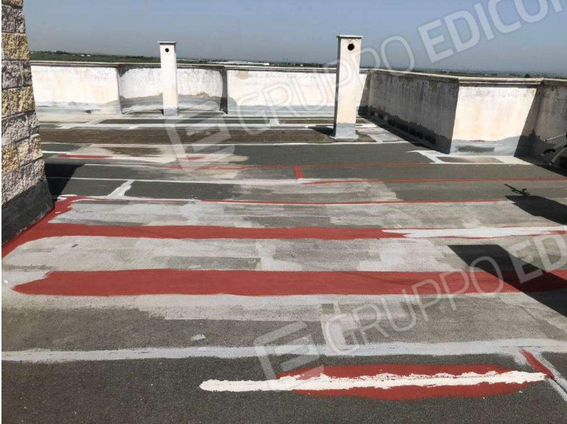
Foto n. 17 – I lastrici solari
