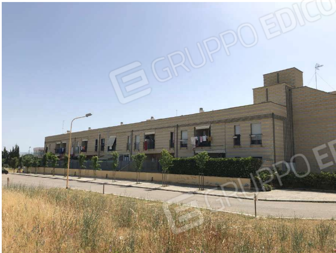
Foto n. 3 – Blocco A: prospetto retrostante
