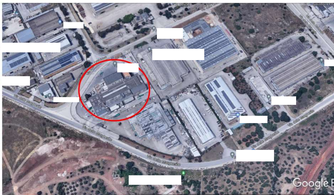
Fig. 1 – Immagine aerea dell'immobile tratta da Google Earth
