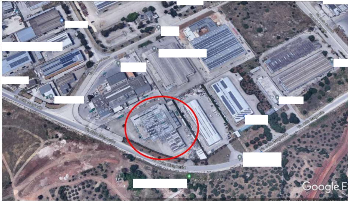
Fig. 2 – Immagine aerea dell'immobile tratta da Google Earth
