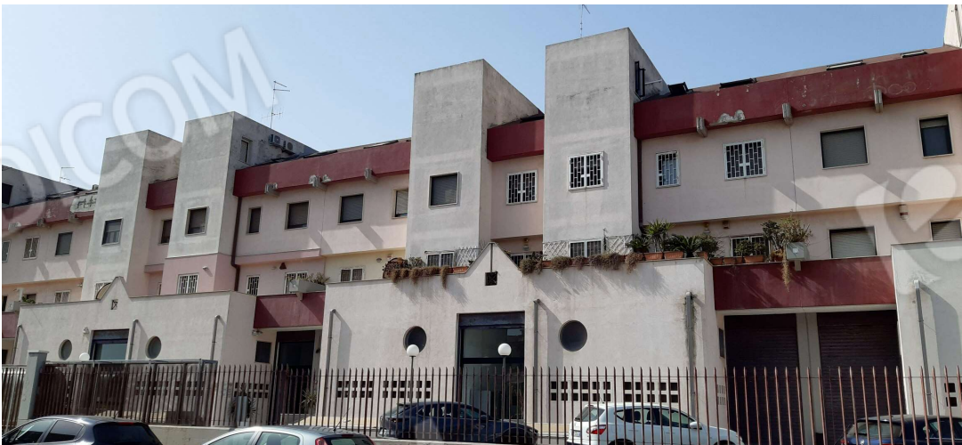
Prospetto posteriore prospiciente via Ottorino Respighi - foto 03
