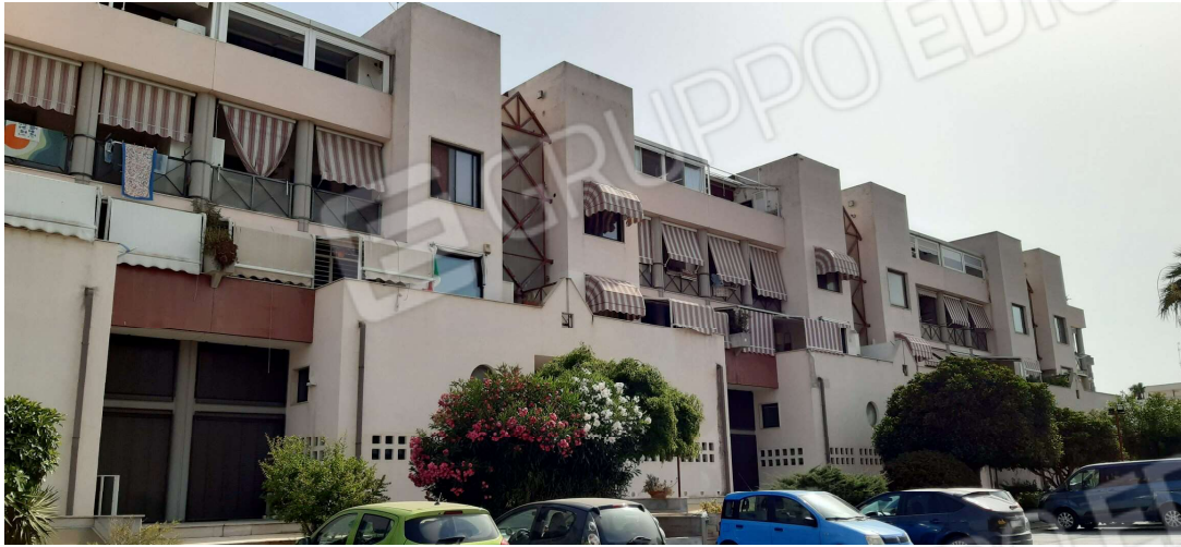
Immobile in via Vincenzo Corrado nn. 12/14 – prospetto anteriore - foto 01
