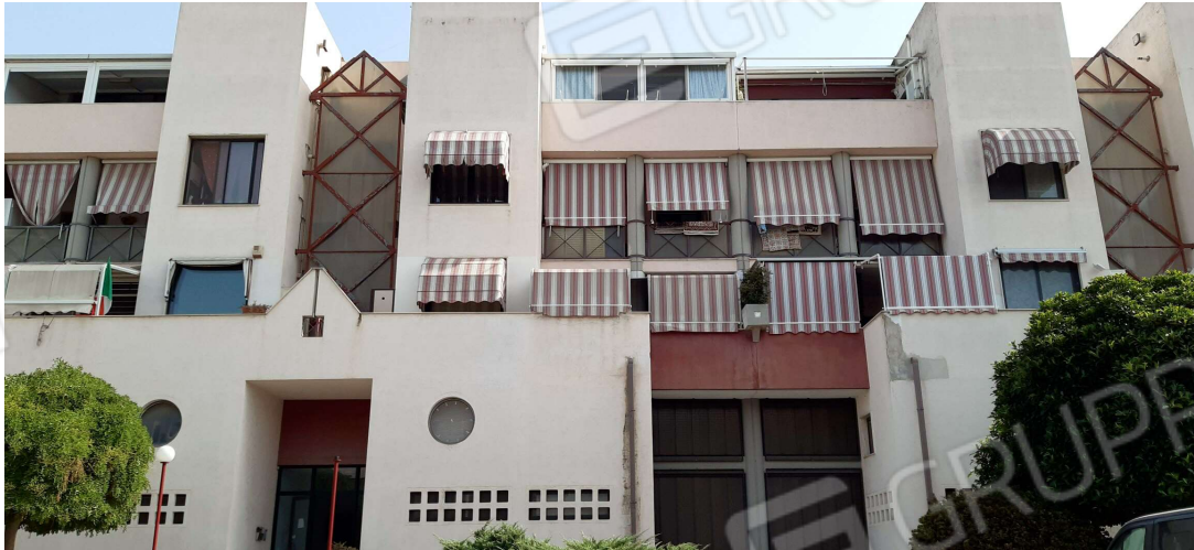
Prospetto anteriore prospiciente via Vincenzo Corrado - foto 02
