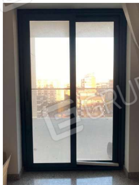
Foto 23 – Particolare infisso esterno
