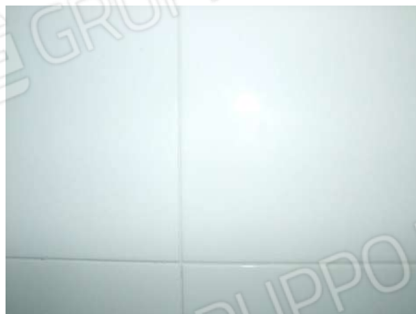
Foto 21 – Particolare rivestimento bagni
