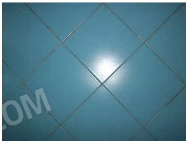
Foto 20 – Particolare pavimentazione bagni
