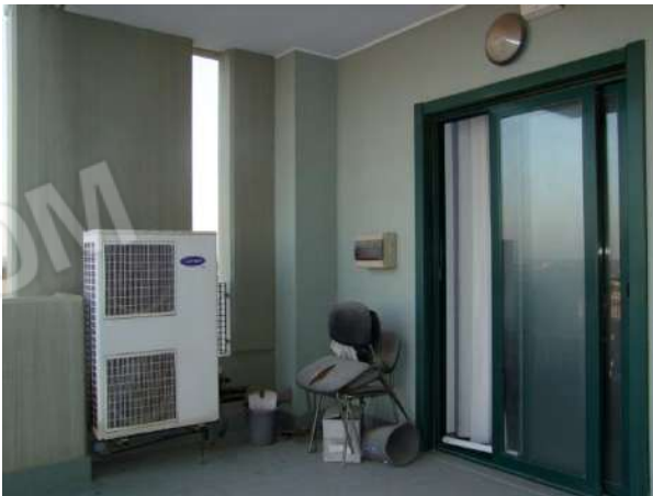
Foto 11 - Vista verso la parete con la portafinestra dell'Ufficio2
