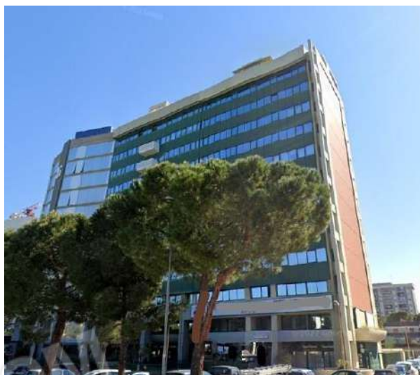
Foto 1 – Vista dell'edificio. Prospetto su Via don L. Guanella
