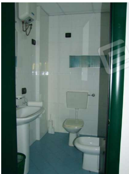
Foto 14 - Vista interna del bagno WC1
