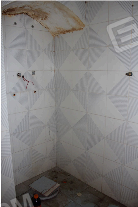
Foto 6 (Vista dell'unità immobiliare censita al Sub. 4)
