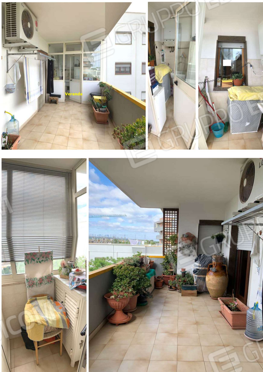
Foto nn. 32-33-34-35-36. Piano Secondo. Balcone 2 chiuso in parte da veranda
