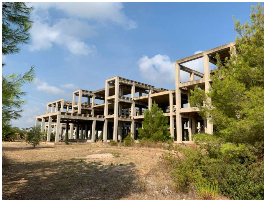
FOTO 14 - STRUTTURA ALBERGHIERA A RUSTICO
