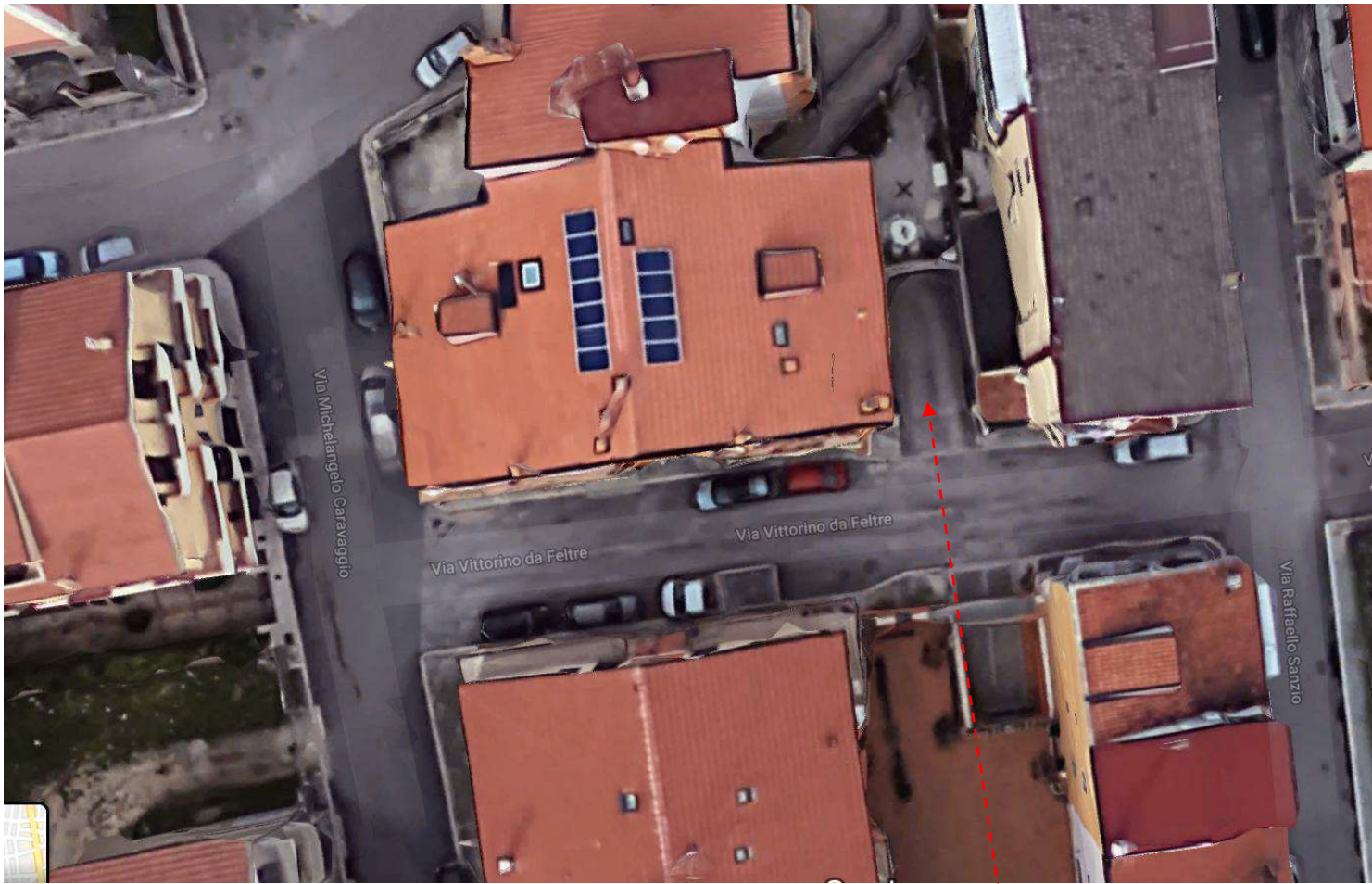
LOTTI 3 – 4 – 5 - Accesso all'interrato in via Feltre - San Giovanni R.do fgl 143 p.IIa 461
