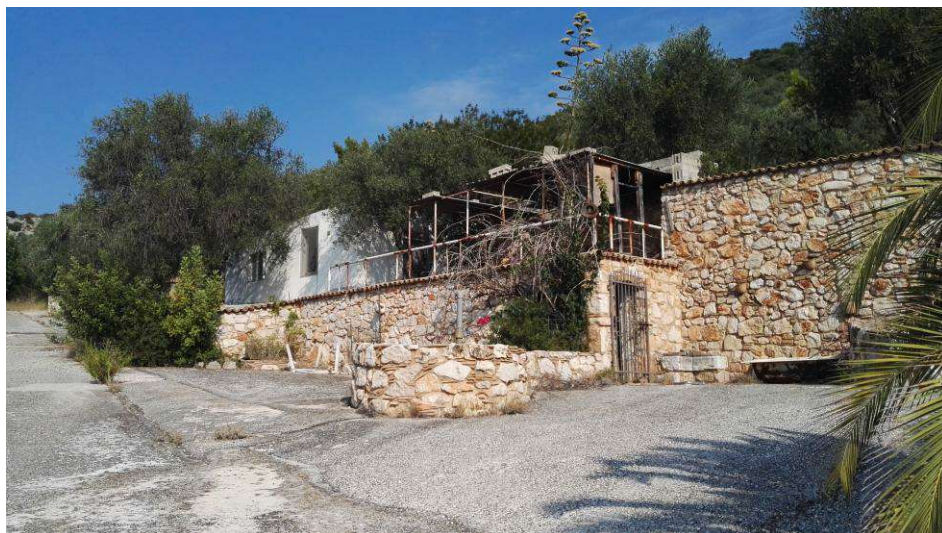
Il fabbricato in basso
