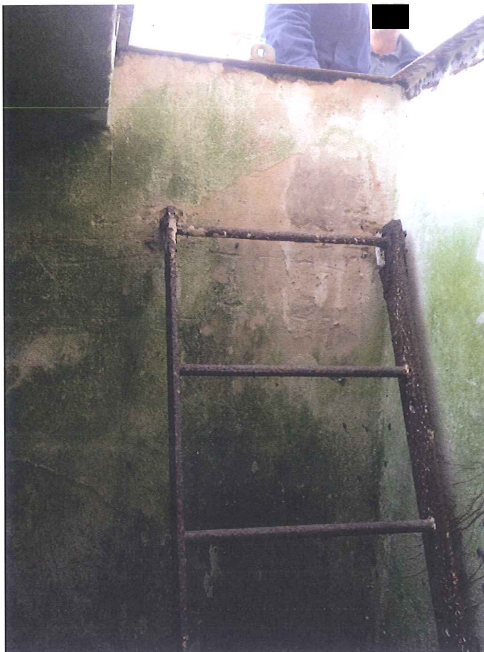
Pozzo (A): accesso dalla botola superiore
