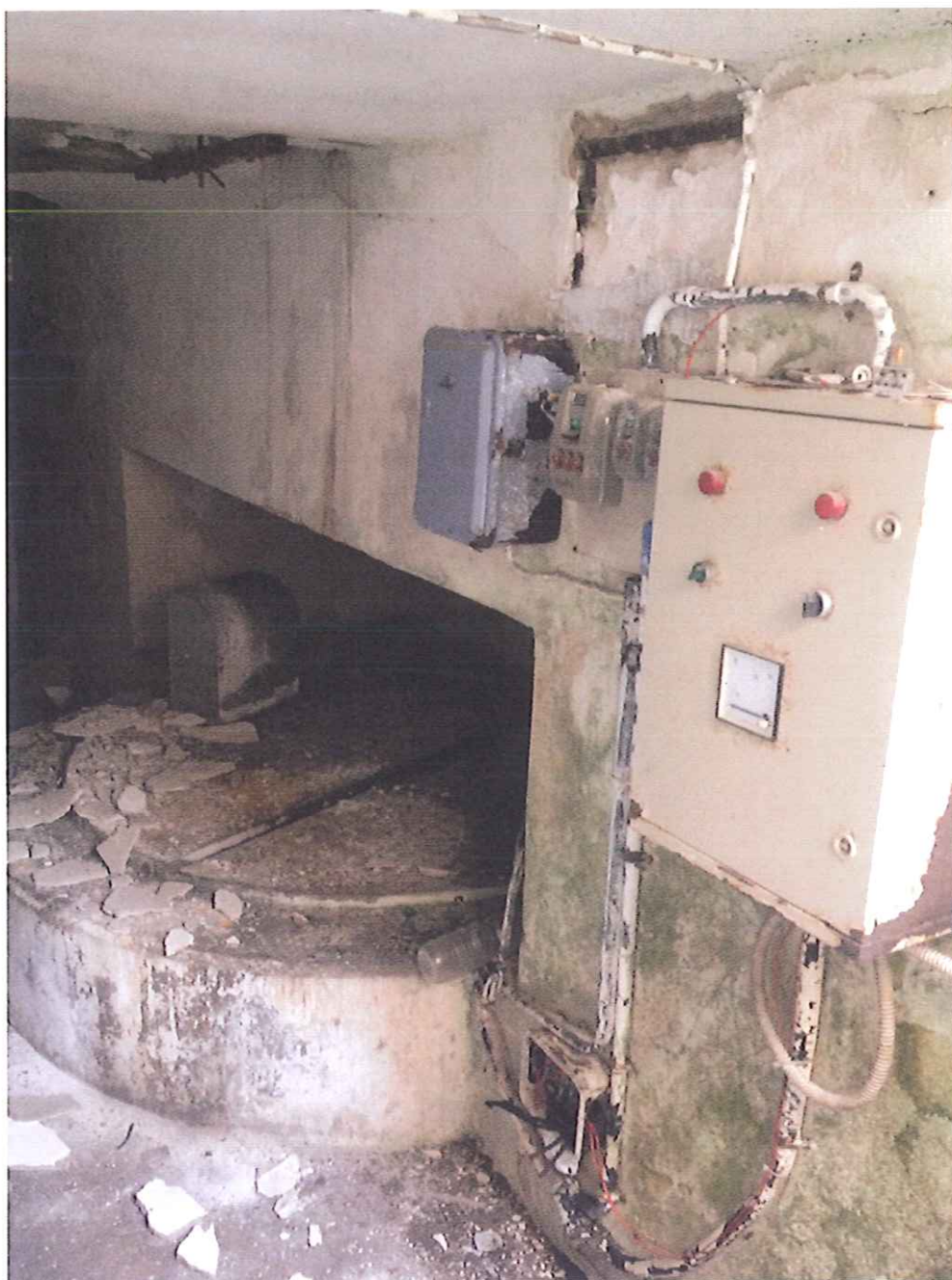
Pozzo (A): interno del vano
