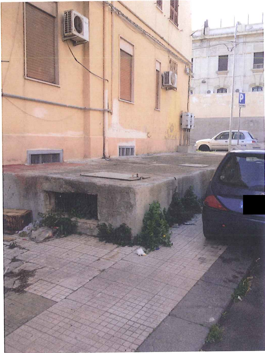
Pozzo (A): esterno del vano
