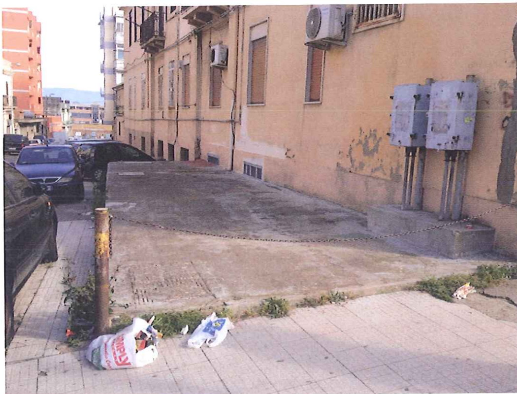
Pozzo (A): esterno del vano
