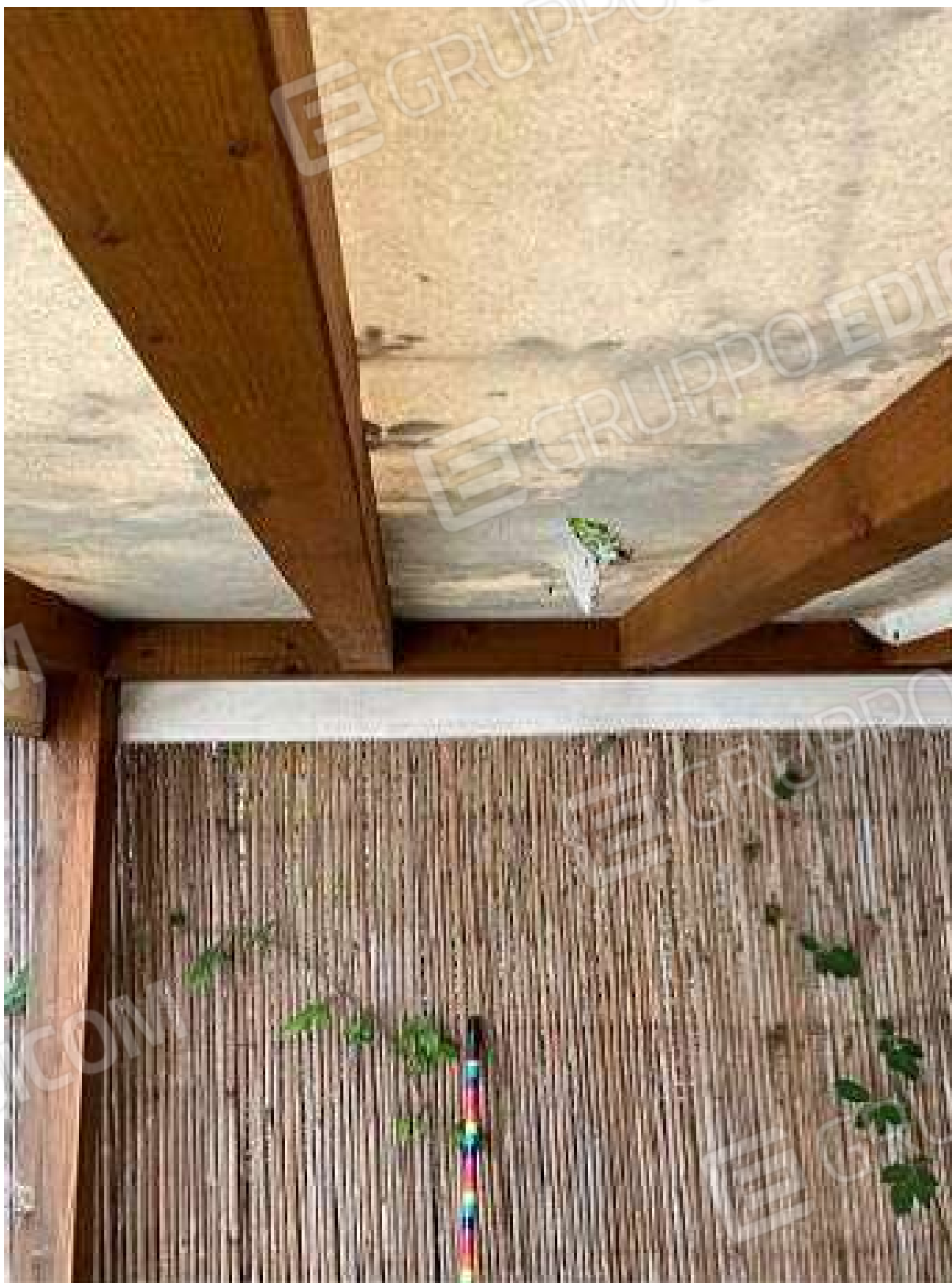
Figura 4. Fotografia scattata ad una delle coperture in PVC in cui si evidenzia la struttura lignea e uno strappo al telo in PVC
