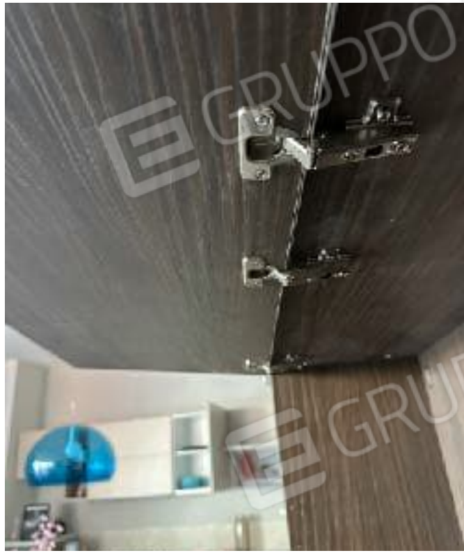
Figura 21 – Lotto 005 – Dettaglio ribalta – criticità funzionale rilevata
