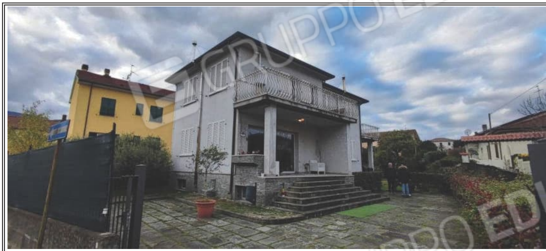
Foto n. 1 – Vista del fabbricato - angolo EST
