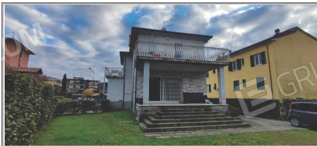
Foto n. 3 – Vista fabbricato – angolo NORD
