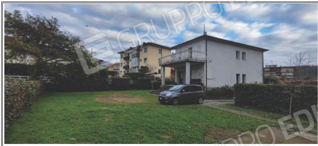
Foto n. 4 – Vista del fabbricato - Angolo OVEST
