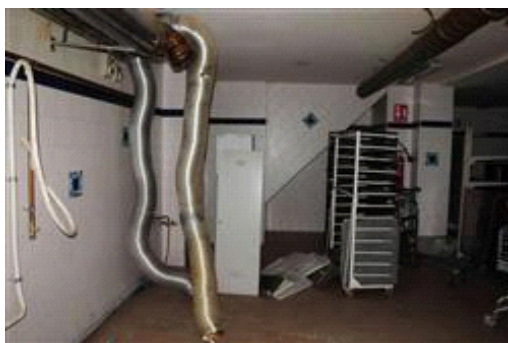
Interno, ripresa verso ovest
