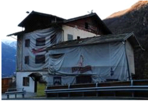
Ripresa da nord est del fabbricato: in primo piano corpo nord
