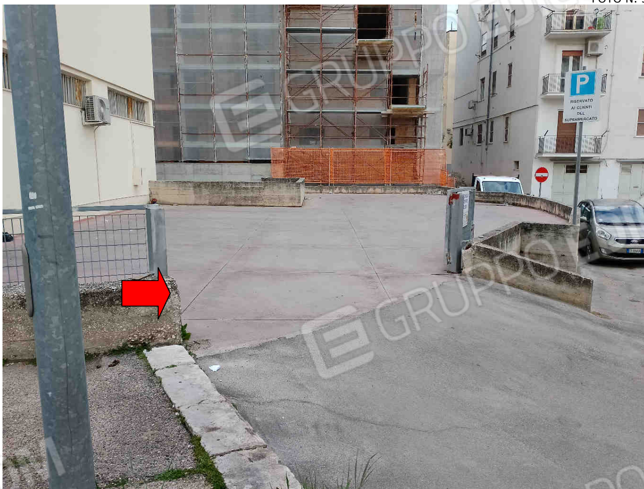
LASTRICO SOLARE PARCHEGGIO FG. 70 PARTICELLA 2133 SUB 9 E PARTICELLA 2135 SUB 9 - ACCESSO
