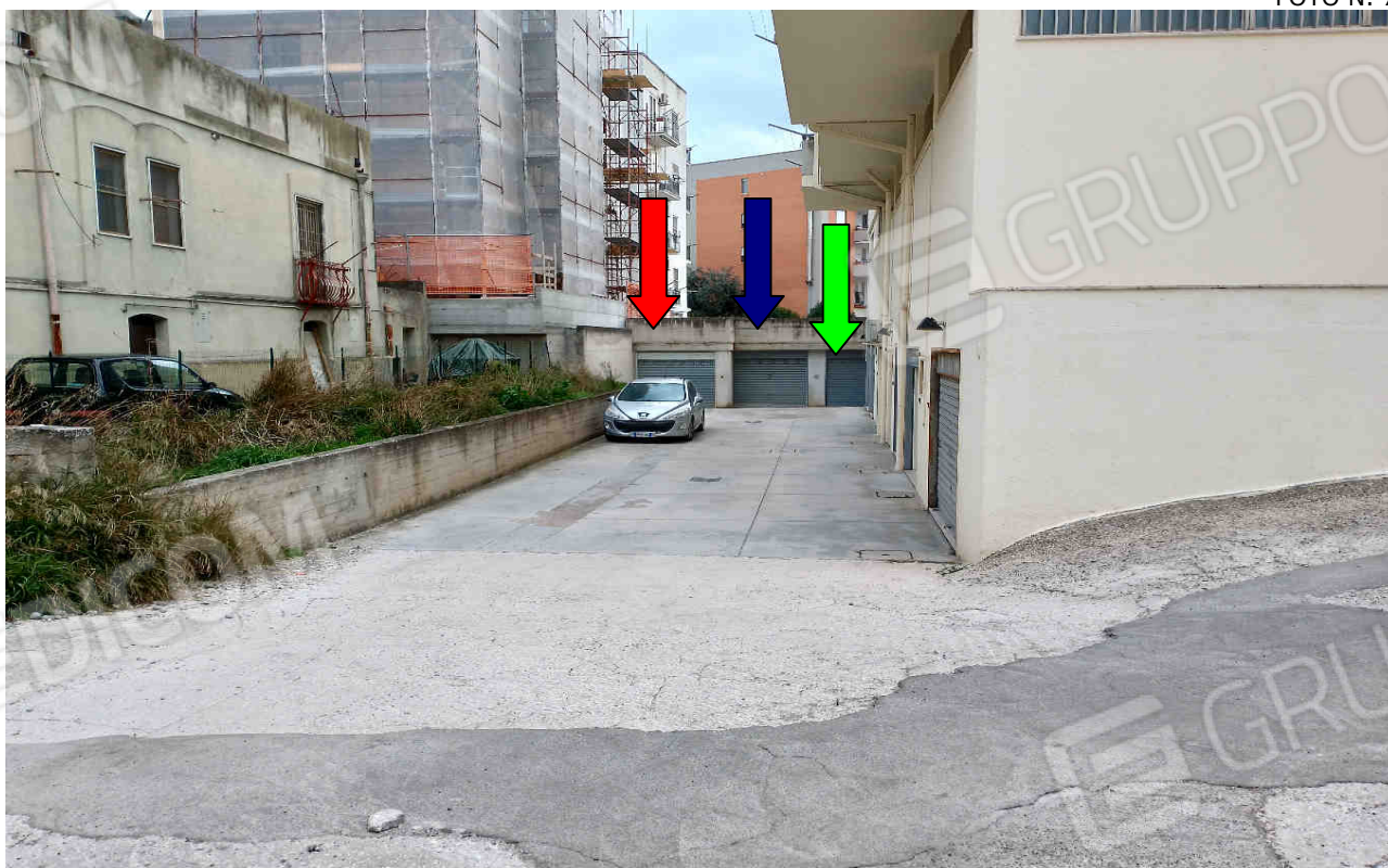
AREA FG. 70 PARTICELLA 2131 – CORSIA DI ACCESSO GARAGE
