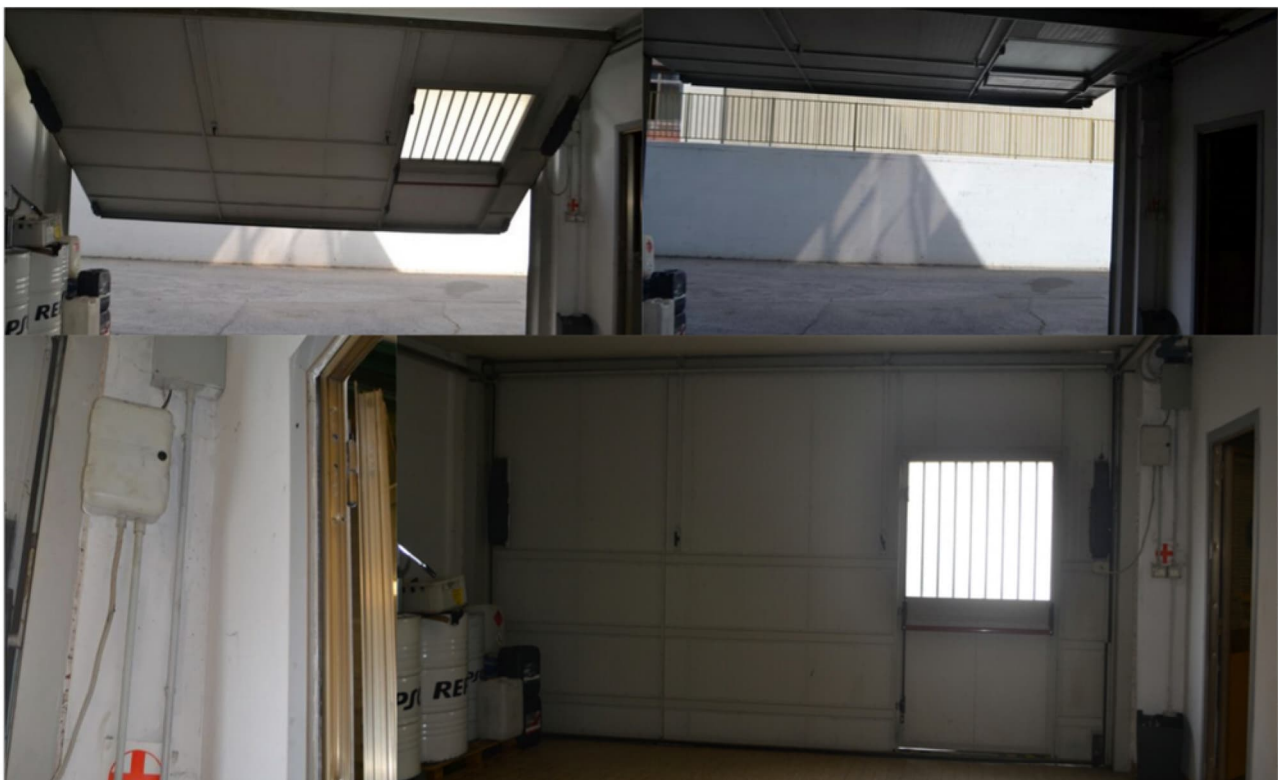
FIG.5-6-7-8 ESTERNO-PORTONE INGRESSO MAGAZZINO/LOCALE DEPOSITO
