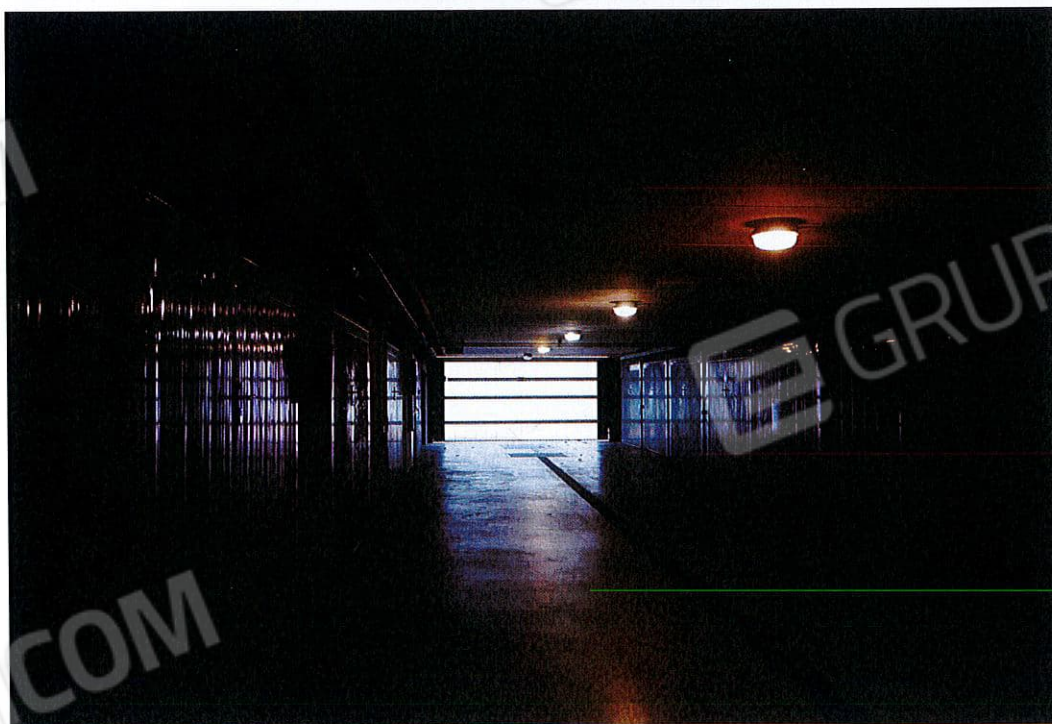
FOTO 6 - Piano interrato. La corsia di manovra.
