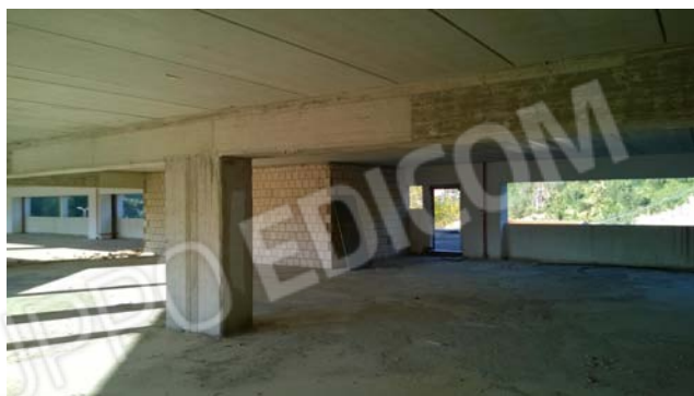
Foto 58 - LOTTO 5 - Piano 2° - sub.466
