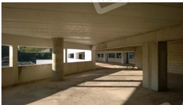
Foto 57 - LOTTO 5 - Piano 2° - sub.466
