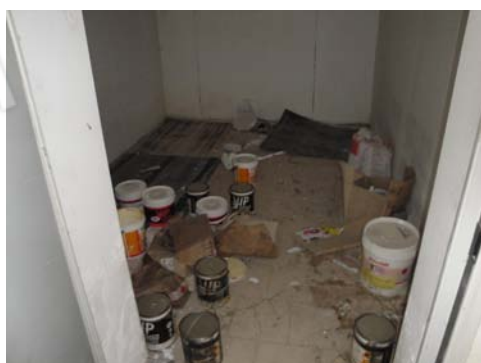
Foto 31 - LOTTO 2 - Piano S1 - sub.328
