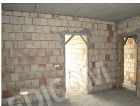
Foto 73 - LOTTO 6 - Piano 4° - sub.204
