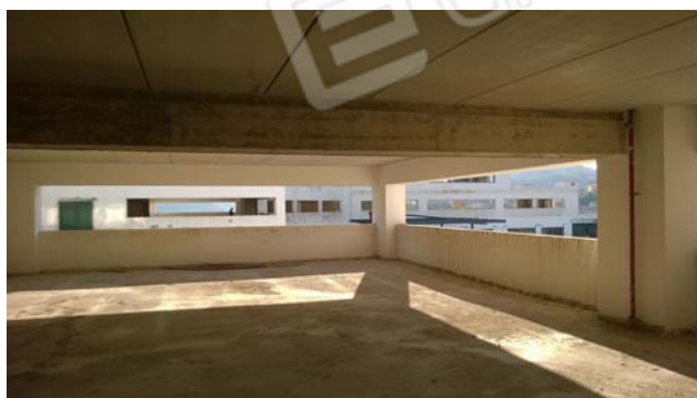
Foto 66 - LOTTO 5 - Piano 2° - sub.467
