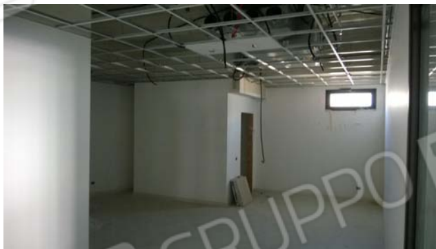
Foto 47 - LOTTO 4 - Piano 1° - sub.106
