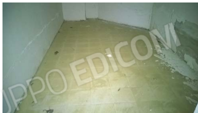
Foto 21 - LOTTO 1 - Piano S2 - sub.292
