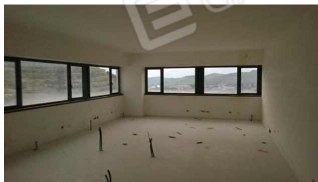
Foto 76 - LOTTO 6 - Piano 4° - sub.221
