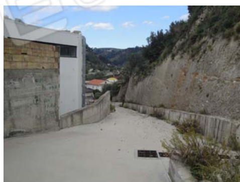
Foto 18 - Prospetto lato monte e strada "Colle Antenna"
