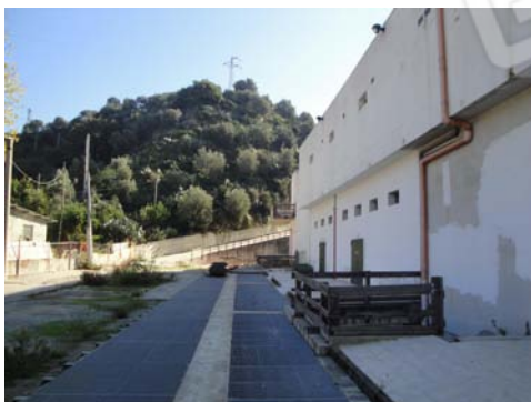
Foto 13 - Prospetto lato Funicolare
