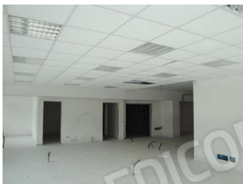
Foto 75 - LOTTO 6 - Piano 4° - sub.205
