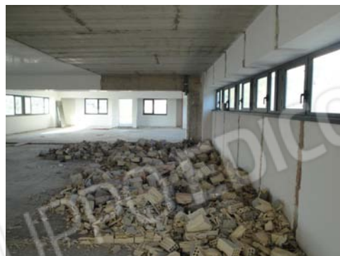
Foto 70 - LOTTO 6 - Piano 4° - sub.219
