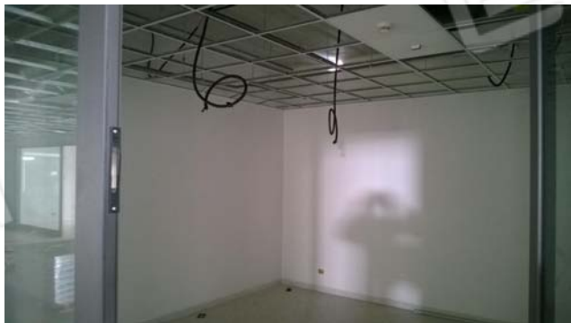
Foto 49 - LOTTO 4 - Piano 1° - sub.141
