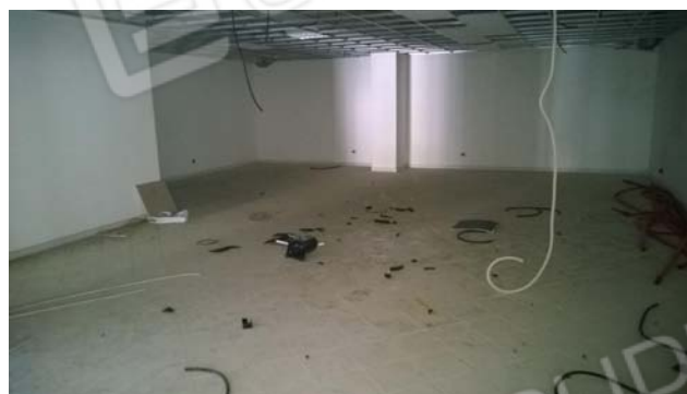
Foto 54 - LOTTO 4 - Piano 1° - sub.256
