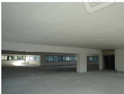
Foto 67 - LOTTO 6 - Piano 4° - sub.219
