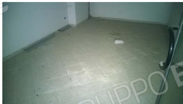
Foto 52 - LOTTO 4 - Piano 1° - sub.251
