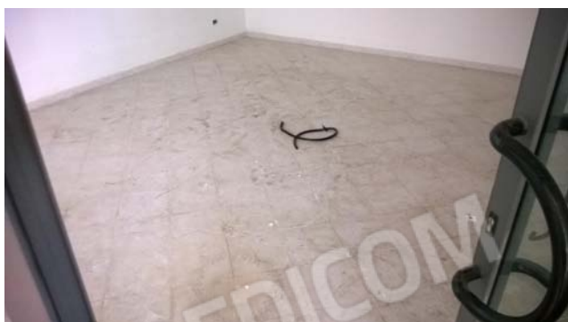
Foto 55 - LOTTO 4 - Piano 1° - sub.270
