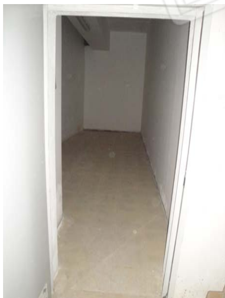
Foto 22 - LOTTO 1 - Piano S2 - sub.152
