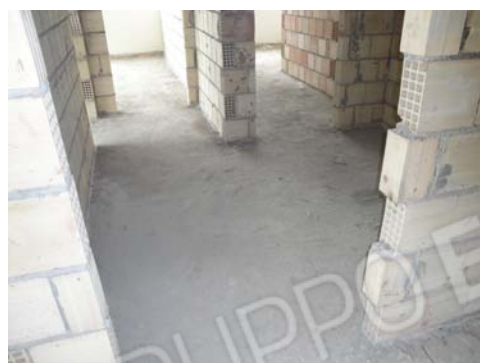
Foto 72 - LOTTO 6 - Piano 4° - sub.202
