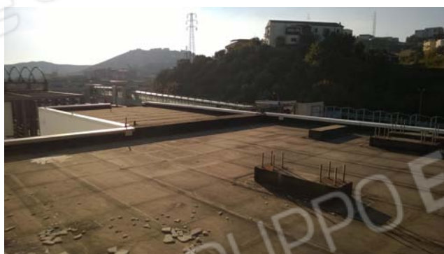
Foto 62 - LOTTO 5 - Piano 2° - sub.466
