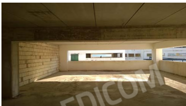
Foto 65 - LOTTO 5 - Piano 2° - sub.467
