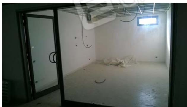
Foto 56 - LOTTO 4 - Piano 1° - sub.277
