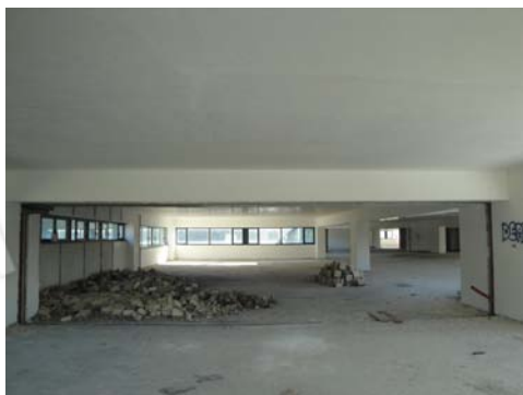
Foto 69 - LOTTO 6 - Piano 4° - sub.219
