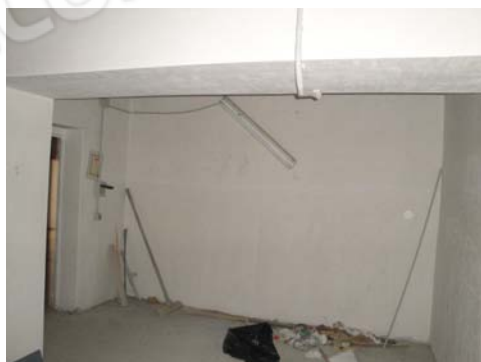
Foto 33 - LOTTO 2 - Piano S1 - sub.330
