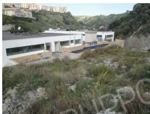
Foto 16 - Prospetto lato monte
