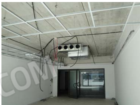
Foto 51 - LOTTO 4 - Piano 1° - sub.242
