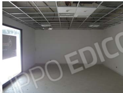
Foto 50 - LOTTO 4 - Piano 1° - sub.233
