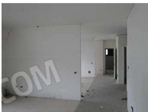
Foto 71 - LOTTO 6 - Piano 4° - sub.201
