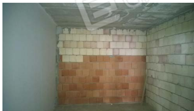
Foto 36 - LOTTO 2 - Piano S1 - sub.335
