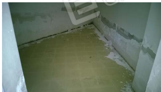
Foto 28 - LOTTO 1 - Piano S2 - sub.318
