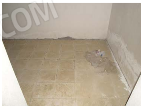
Foto 25 - LOTTO 1 - Piano S2 - sub.302
