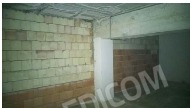
Foto 35 - LOTTO 2 - Piano S1 - sub.333
