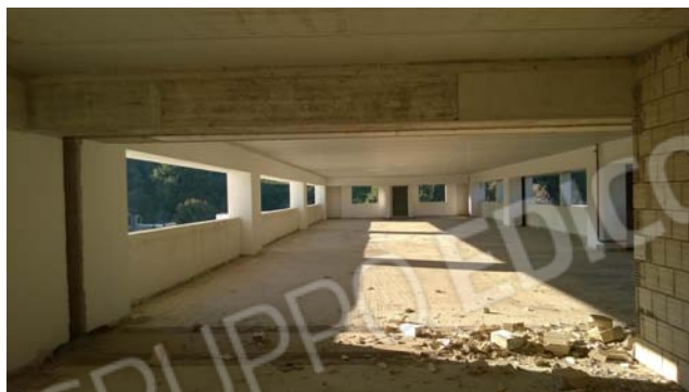
Foto 60 - LOTTO 5 - Piano 2° - sub.466
