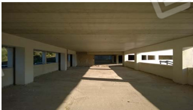
Foto 59 - LOTTO 5 - Piano 2° - sub.466
