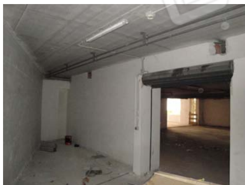
Foto 29 - LOTTO 2 - Piano S1 - sub.326
