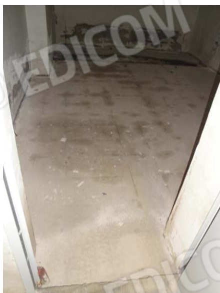
Foto 27 - LOTTO 1 - Piano S2 - sub.317
