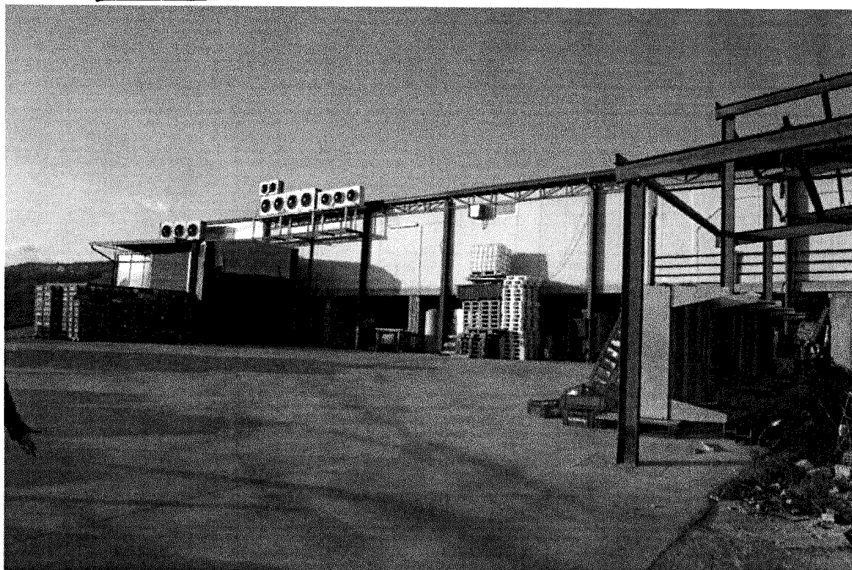
■ Figura 6 [REDACTED] vista accesso alla particella 287 foglio 6 . vista degli esterni.
