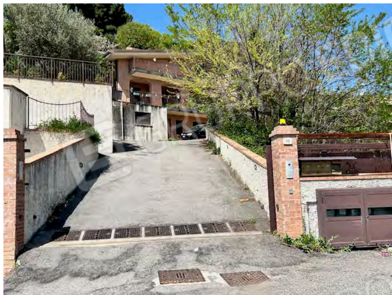
FOTO N. 2: IMM. 01 - 02 - 03 - 04 - FG. 16 - PART. 553 - SUB. 12 - 17 - 18 - 19 - VIA F. SCERBO, 23 - CZ - FABBRICATO
