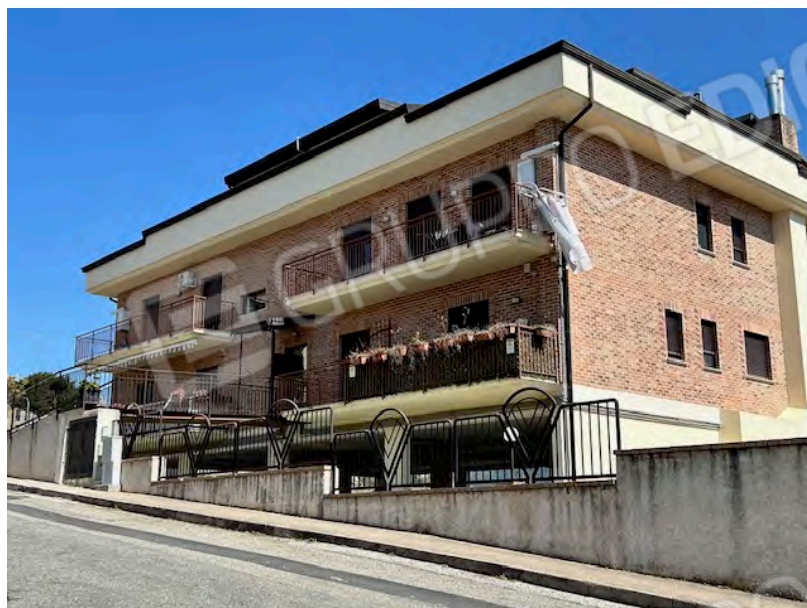
FOTO N. 56: IMM. 16 – FG. 43 - PART. 1221 – SUB. 41 - VIA G. PATARI, 11 - CZ – PIANO PILOTIS
