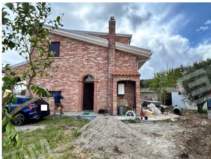
FOTO N. 37: IMM. 11 – FG. 17 - PART. 2813 – SUB. 3 - VIA GIMIGLIANO, 193/A - CZ – VISTA DELL'AREA ESTERNA
