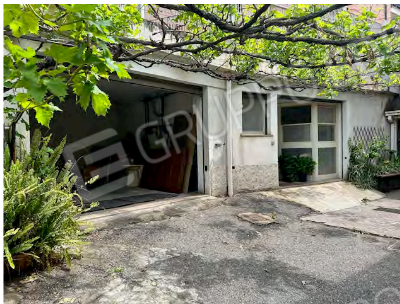
FOTO N. 47: IMM. 14 - FG. 17 - PART. 1093 - SUB. 32 - VIA E. DE SETA, 23 - CZ - VISTA DALL'ESTERNO
