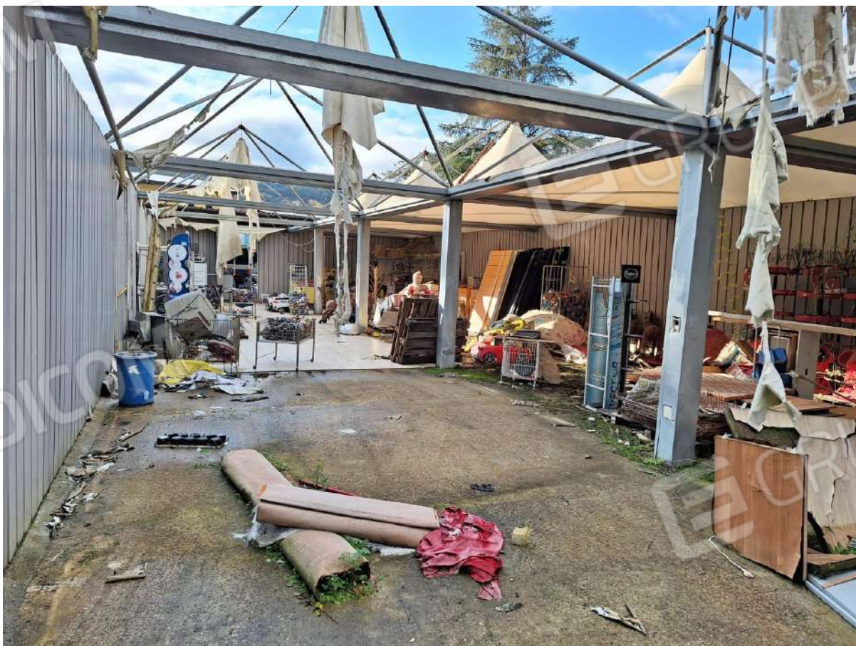
Foto N.24 – Interno gazebo doppi
