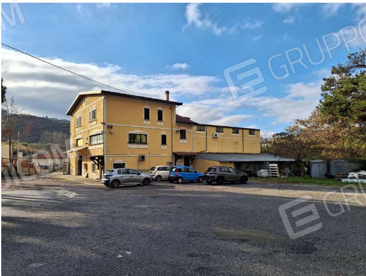
Foto N.2 – Prospetto capannone lato piazzale interno
