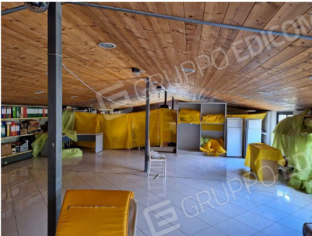
Foto N.19 – Piano sottotetto capannone
