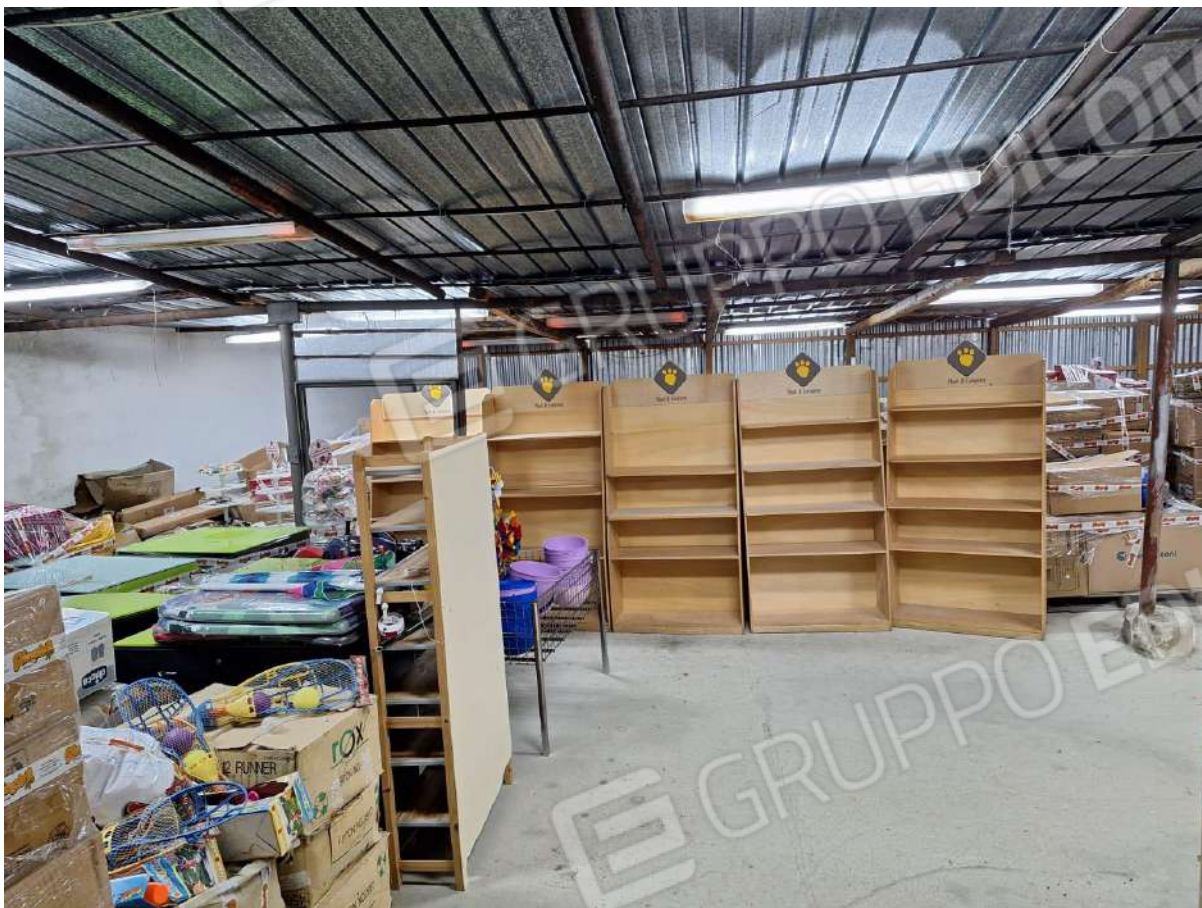
Foto N.11 – Particolare interno tettoia chiusa in lamiera
