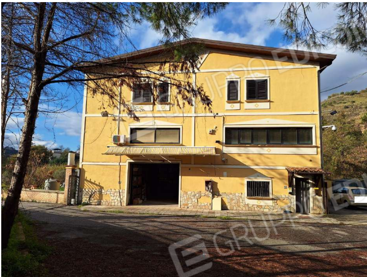
Foto N.1 – Prospetto principale capannone
