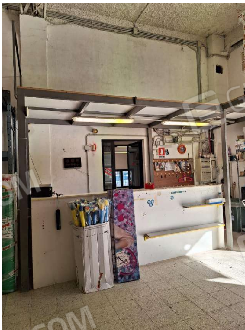
Foto N.8 – Particolare interno capannone con accesso locali ufficio
