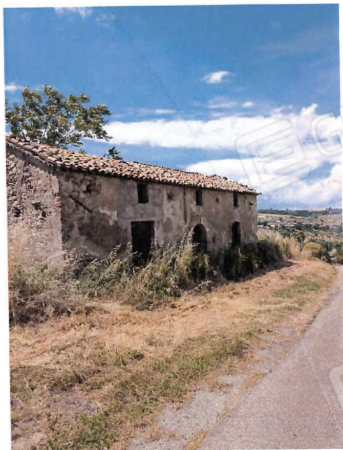
Foto n° 1 - Vista Prospetto Sud -Est
