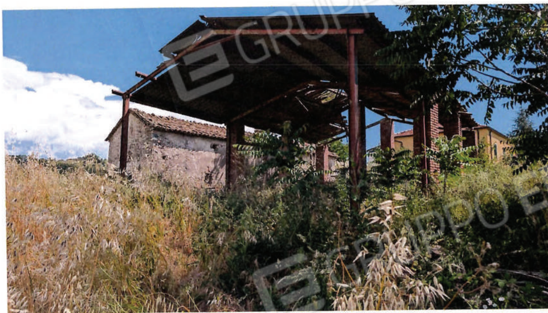
Foto n° 1 - Vista Prospetto Nord -Ovest
