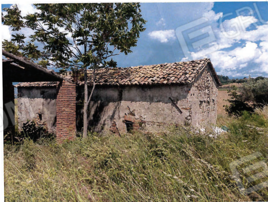
Foto n° 3 - Vista Prospetto Sud -Ovest
