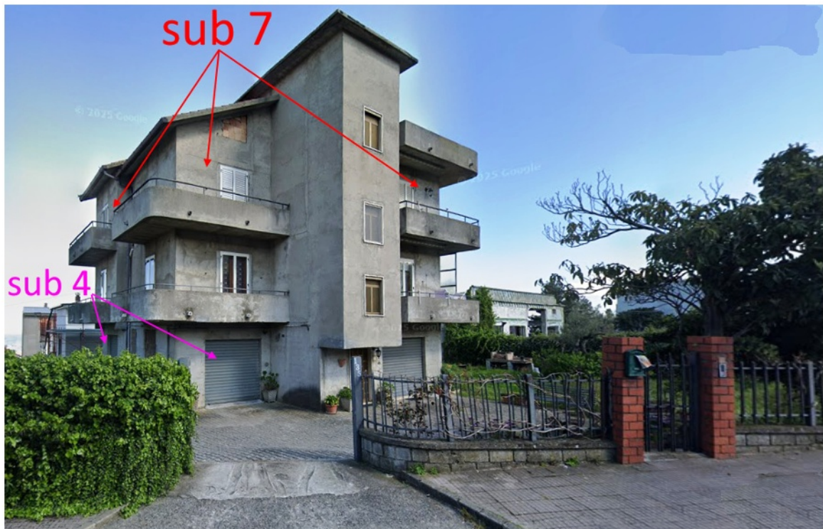
Prospetti ovest e nord del fabbricato ed individuazione dei sub 4 e 7 oggetto di valutazione
