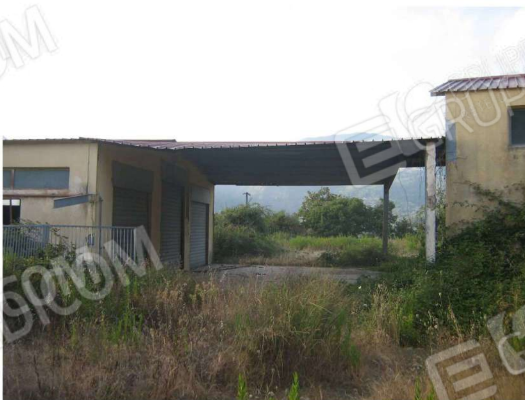
Foto n. 124: tettoia tra i fabbricati “G” e “H”, da sinistra a destra (lotto n. 3).
