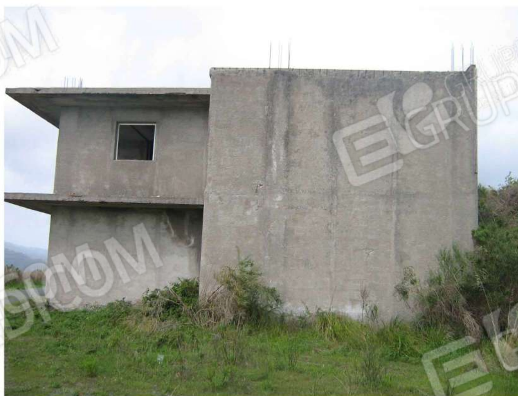
Foto n. 16: prospetto Sud-Ovest del fabbricato “A” (lotto n. 4).
