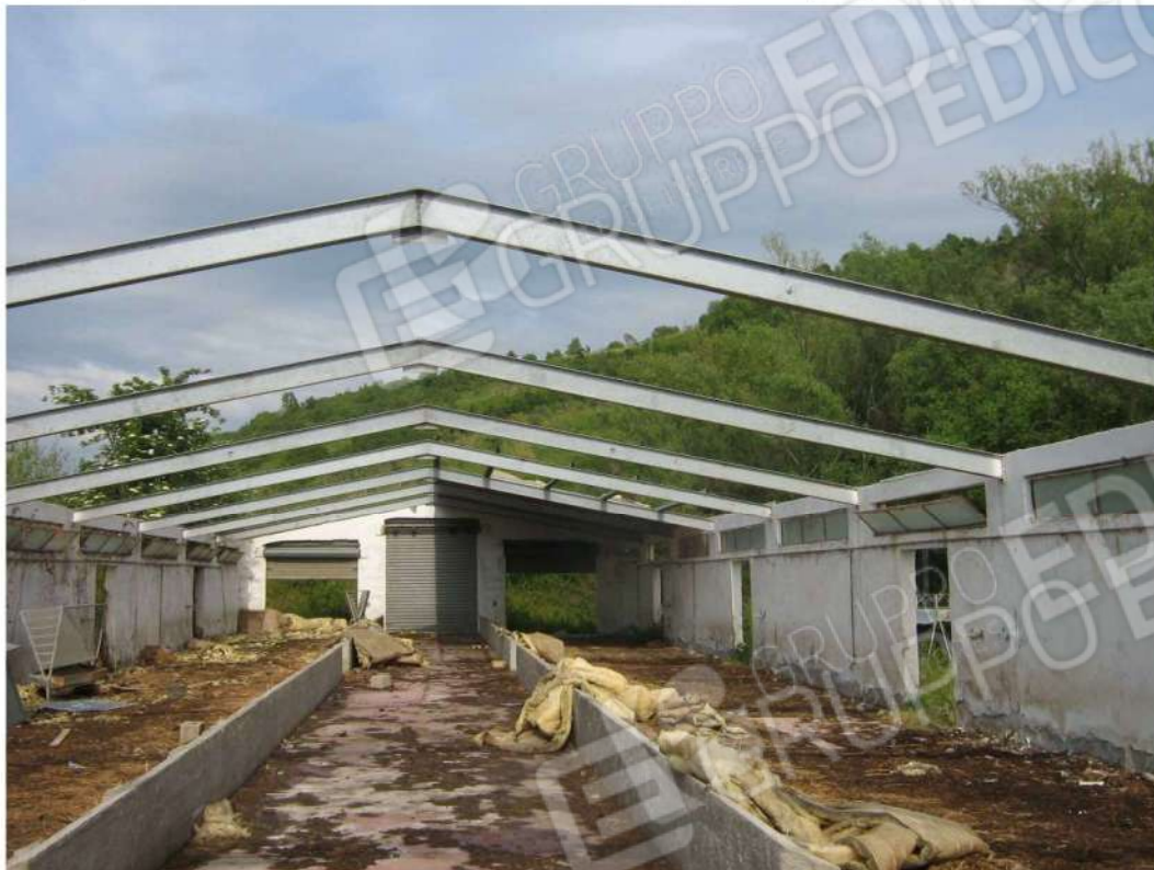
Foto n. 85: particolare struttura di copertura - foto scattata in data 6 maggio 2008 ; da osservare che gli arcarecci, di cui alla fotografia n. 83 sopra riportata, sono stati rimossi - Fabbricato "E" (lotto n. 4).
