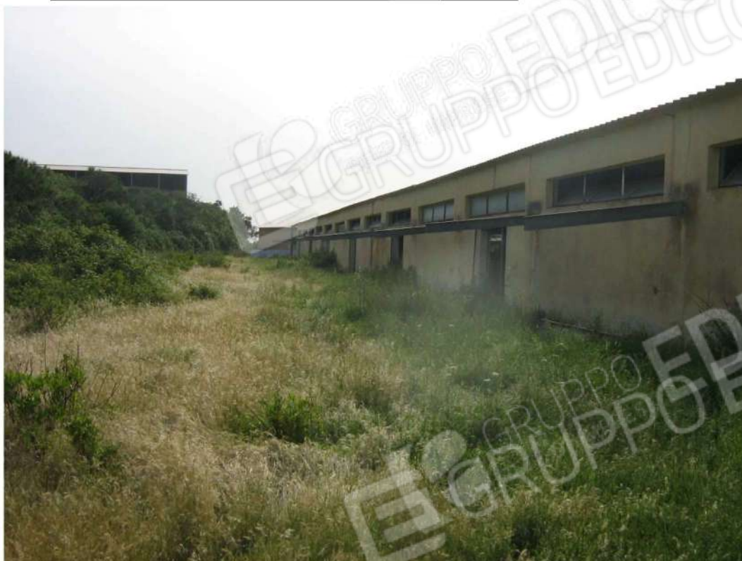
Foto n. 133: foto prospettiva fabbricato “I” (lotto n. 3).
