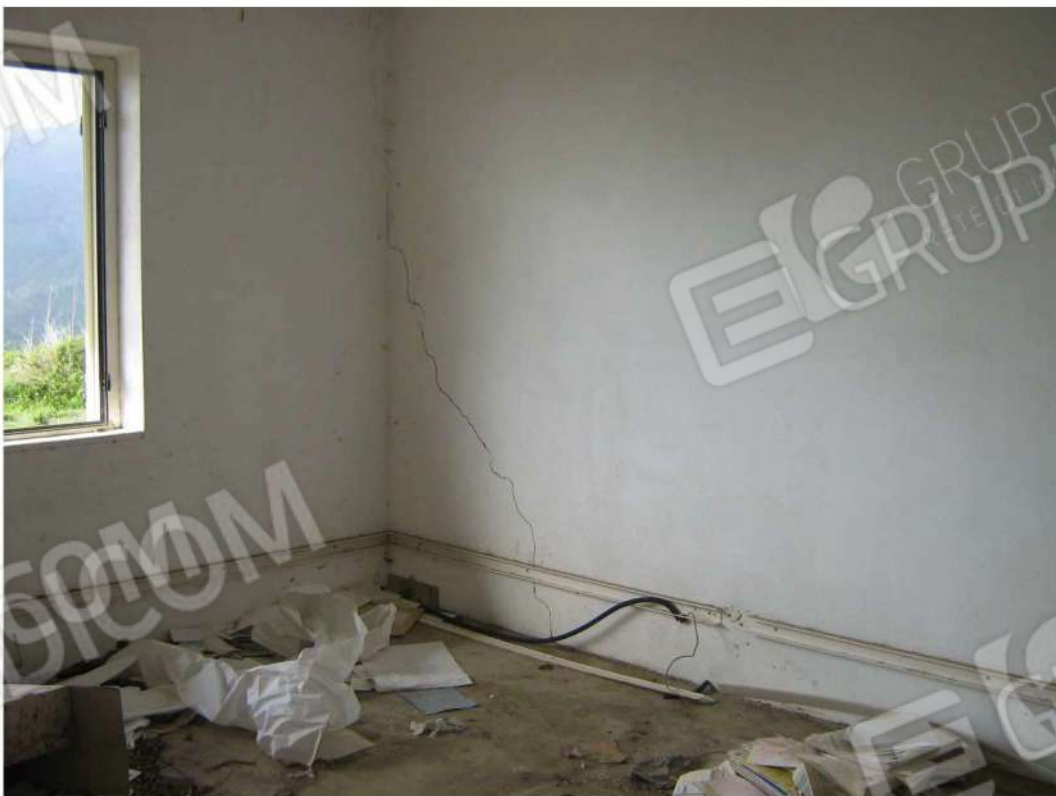
Foto n. 38: particolare vano posto al piano terra; da notare la fessura sub -verticale della parete - Fabbricato "A" (lotto n. 4).
