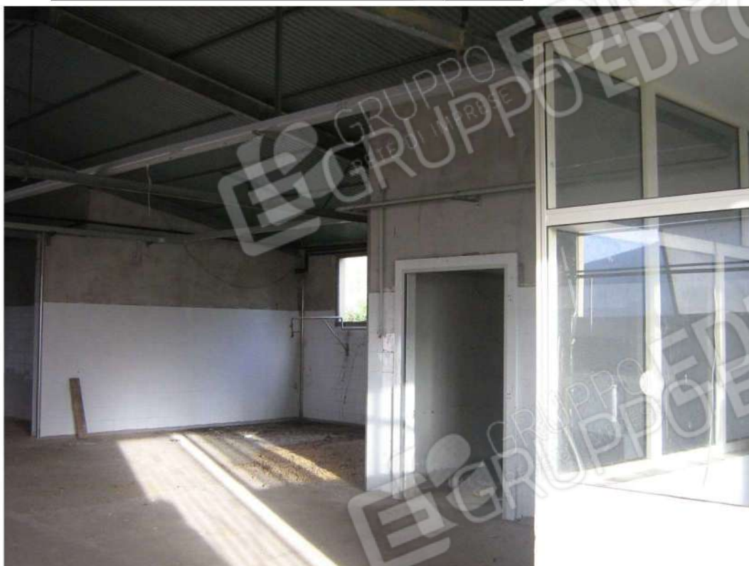
Foto n. 55: particolare ambiente interno - Fabbricato "C" (lotto n. 4).
