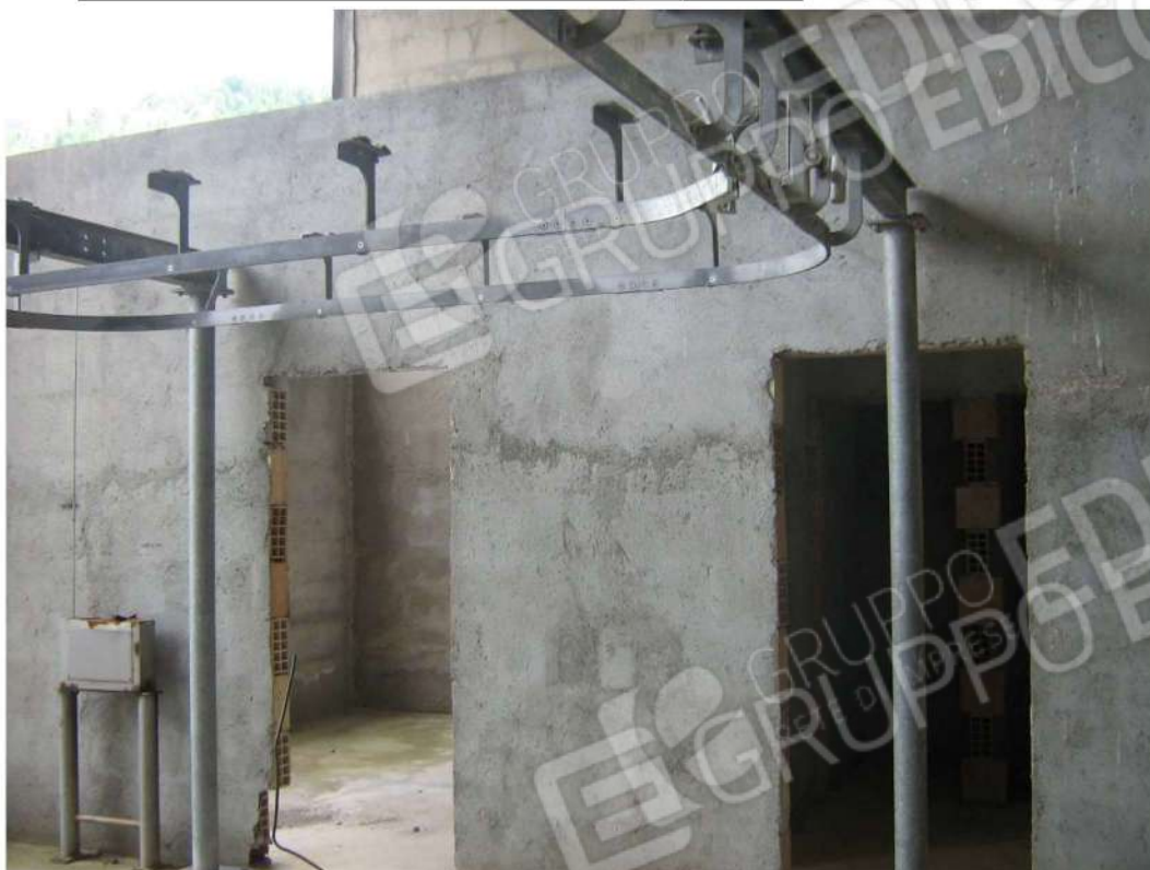
Foto n. 109: particolare nastro trasportatore - Fabbricato "F" (lotto n. 3).
