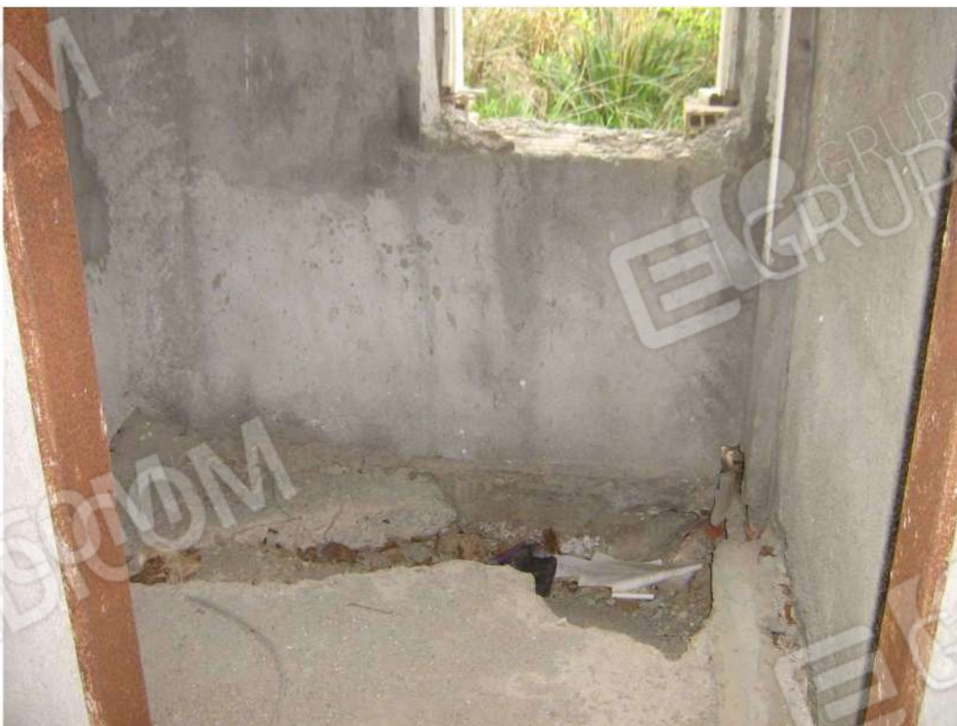
Foto n. 30: particolare traccia necessaria alla realizzazione dell'impianto di scarico - Fabbricato "A" (lotto n. 4).
