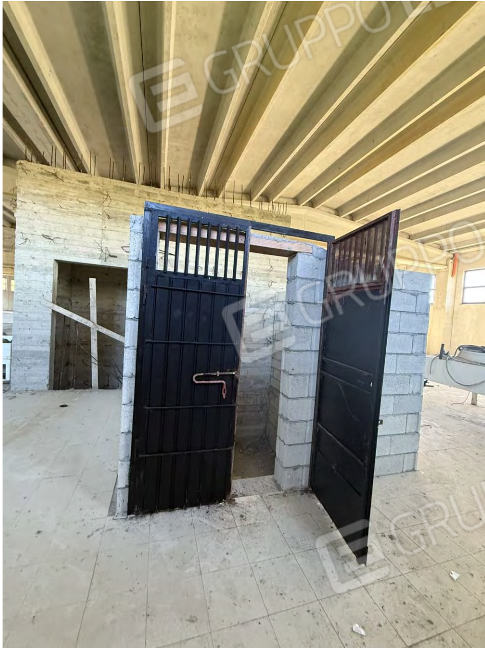
Foto n. 19 Piano terra – Vano scala
