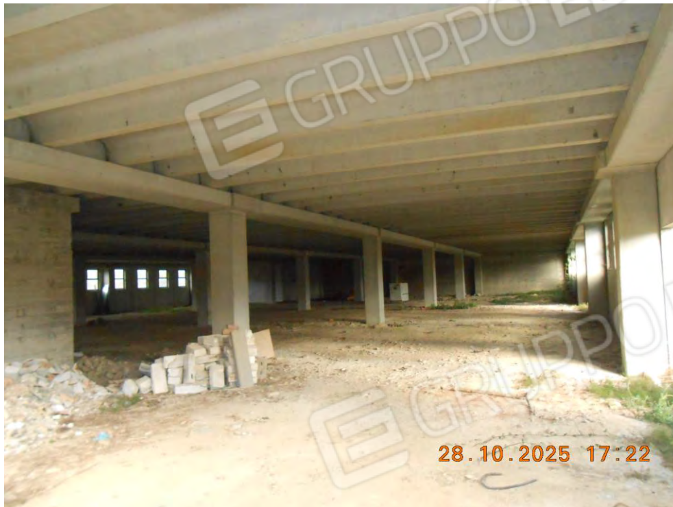
Foto n. 24 Piano seminterrato – Vano da completare
