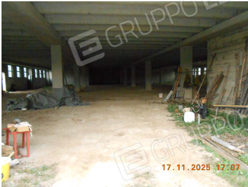
Foto n. 22 Piano seminterrato – Vano da completare
