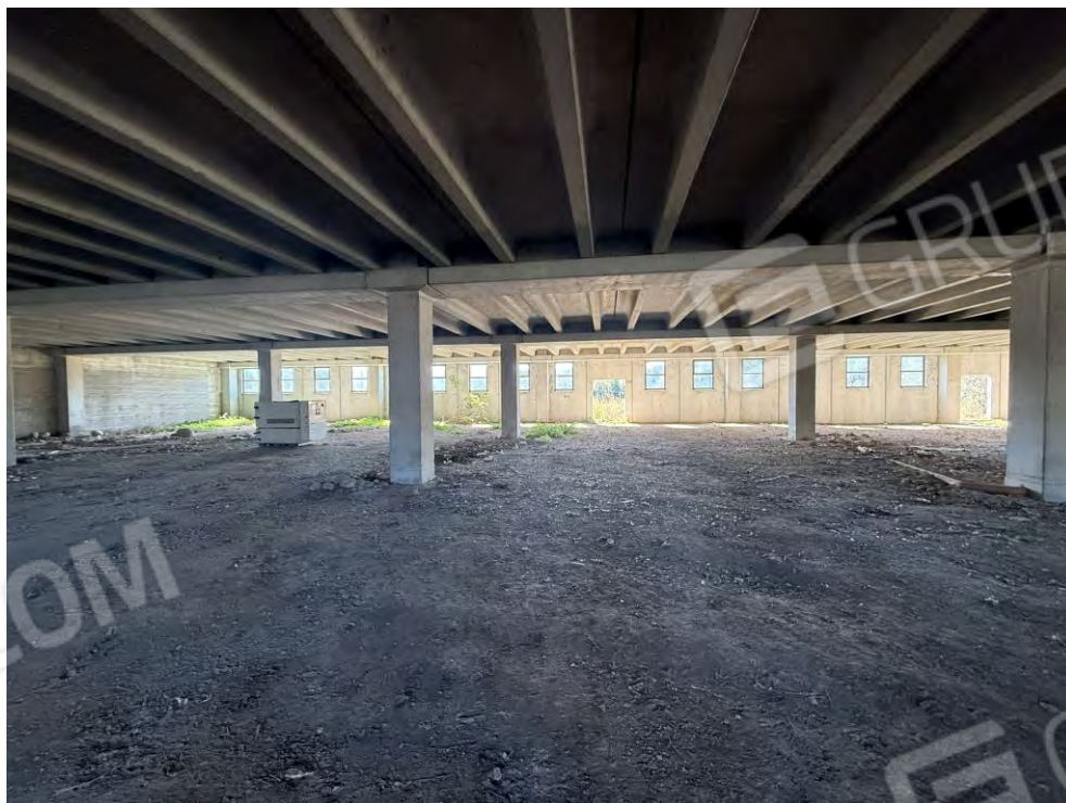
Foto n. 25 Piano seminterrato – Vano da completare
