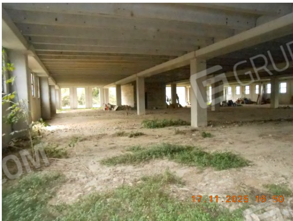
Foto n. 23 Piano seminterrato – Vano da completare
