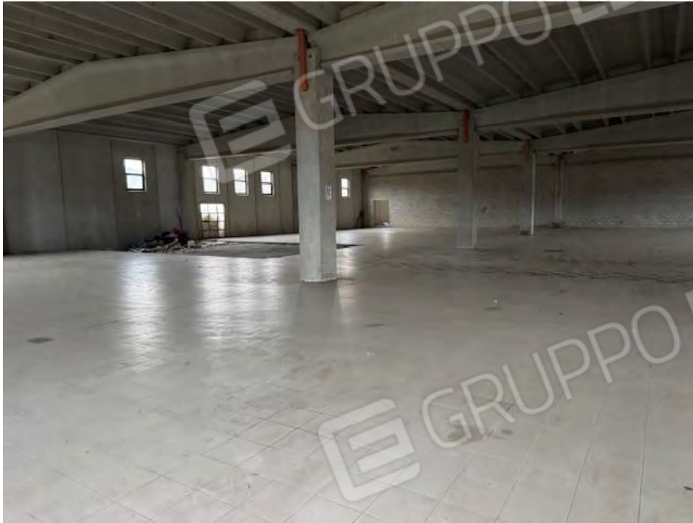
Foto n. 13 Piano terra – Vano 1
