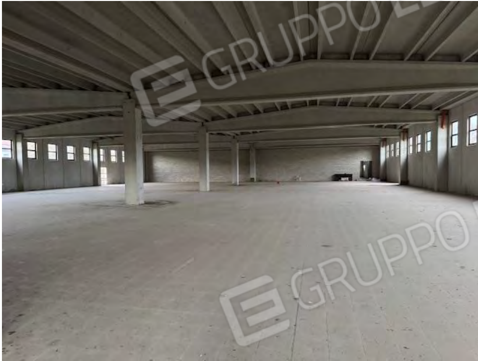
Foto n. 15 Piano terra – Vano 2
