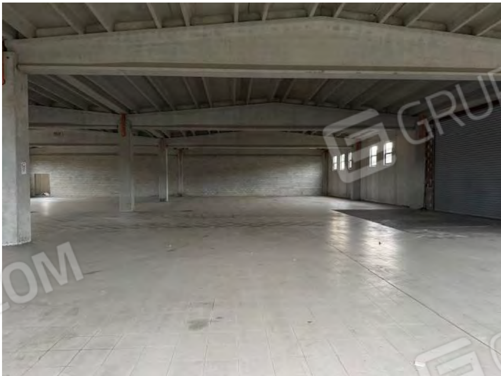
Foto n. 12 Piano terra – Vano 1
