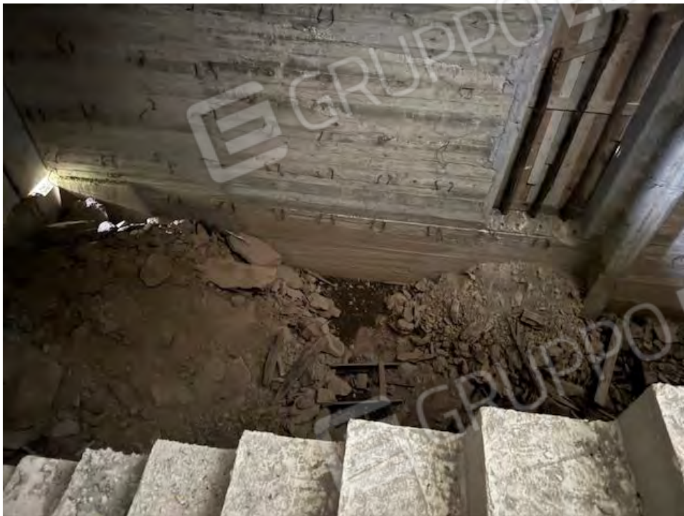
Foto n. 20 Piano terra – Vano scala
