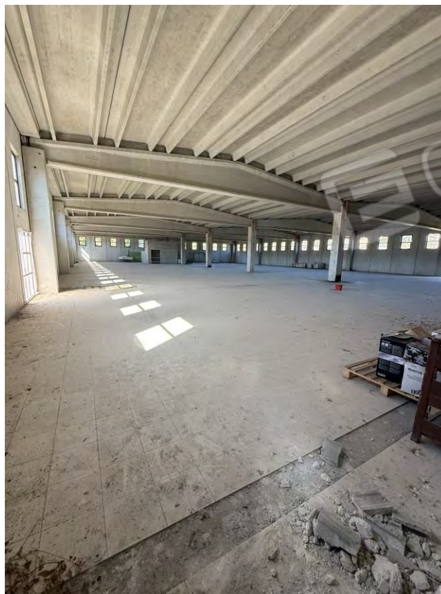
Foto n. 16 Piano terra – Vano 2
