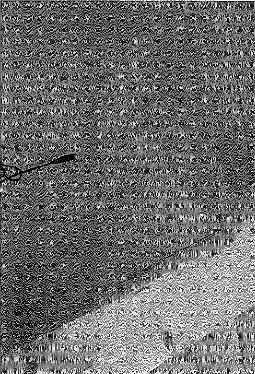
Vista accesso al sottotetto
