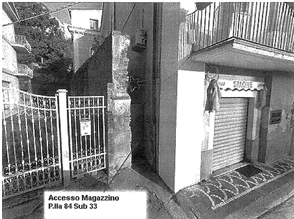
Vista Ingresso Lotto n.2
