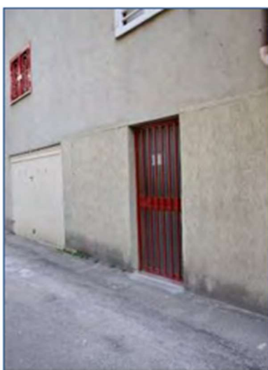
ingresso secondario Scala O, a nord
