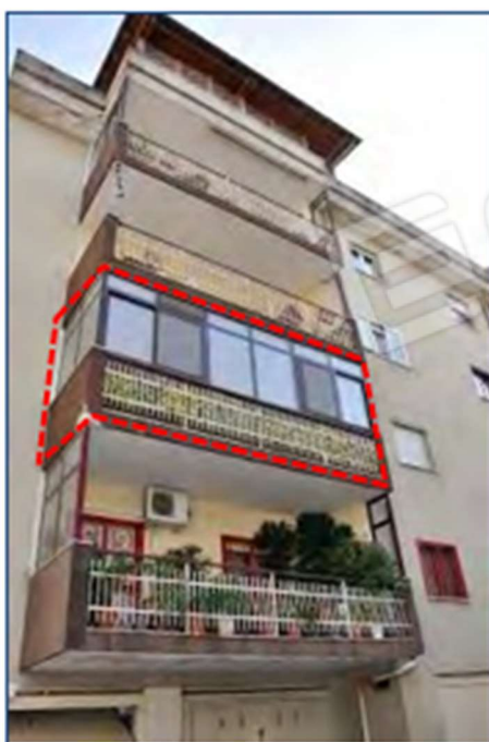
facciata a nord, Scala O
