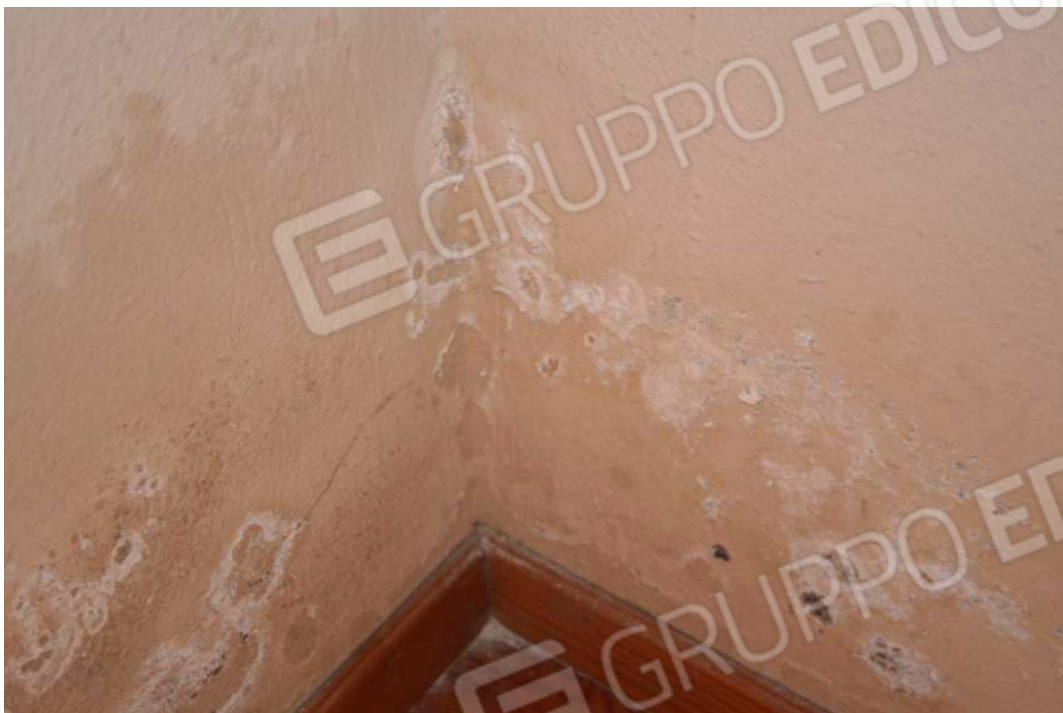
Particolare presenza di umidità in una camera da letto
