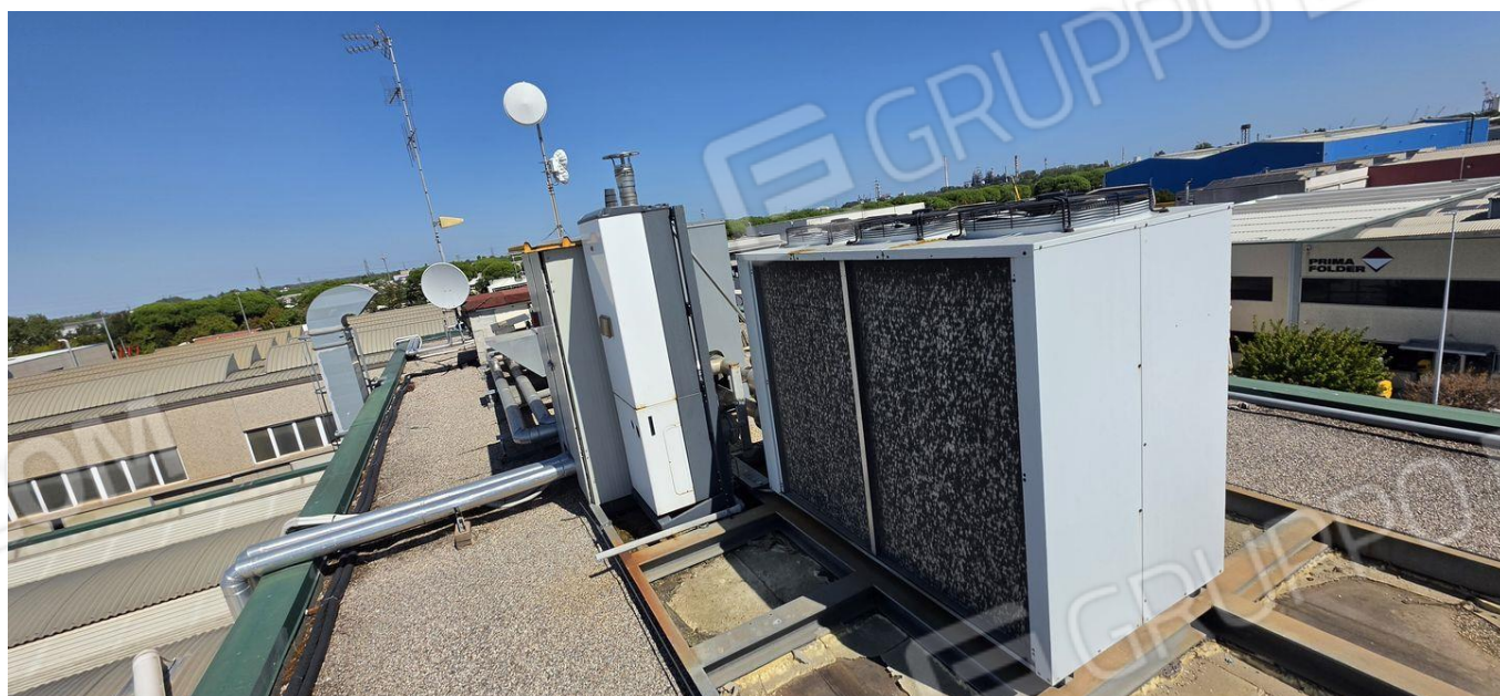
Copertura piana uffici
