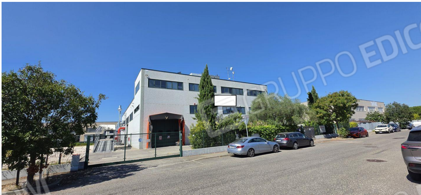
Vista sul fabbricato industriale da via Depretis
