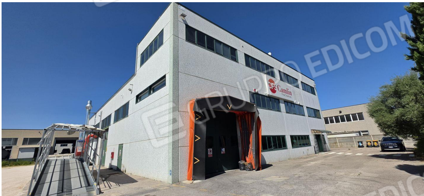
Accesso a magazzino (PT)
