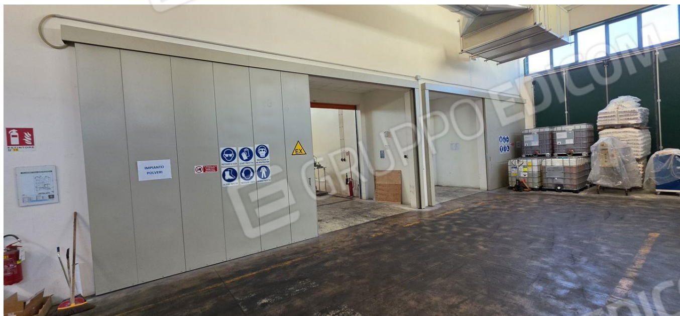
Magazzino – locali dotati di ventilazione forzata e impianti di miscelazione (PT)
