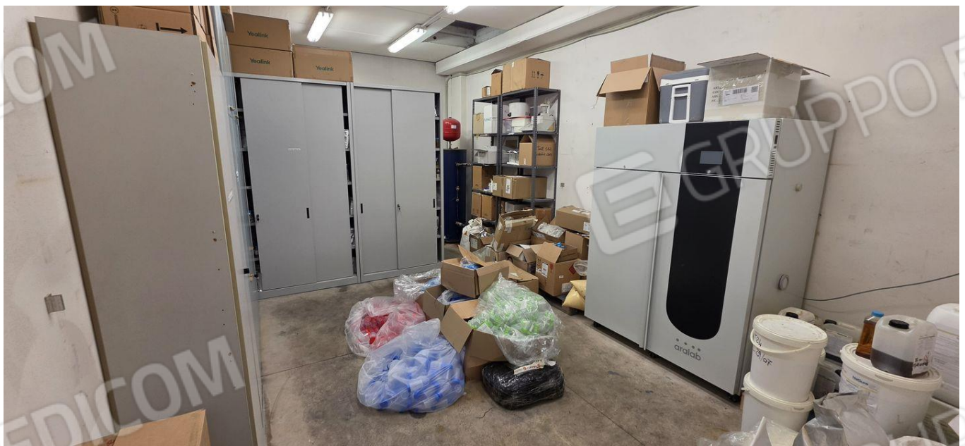
Magazzino – zona servizi (PT)
