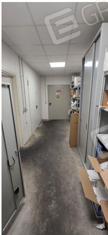
Magazzino - disimpegno (PT)
