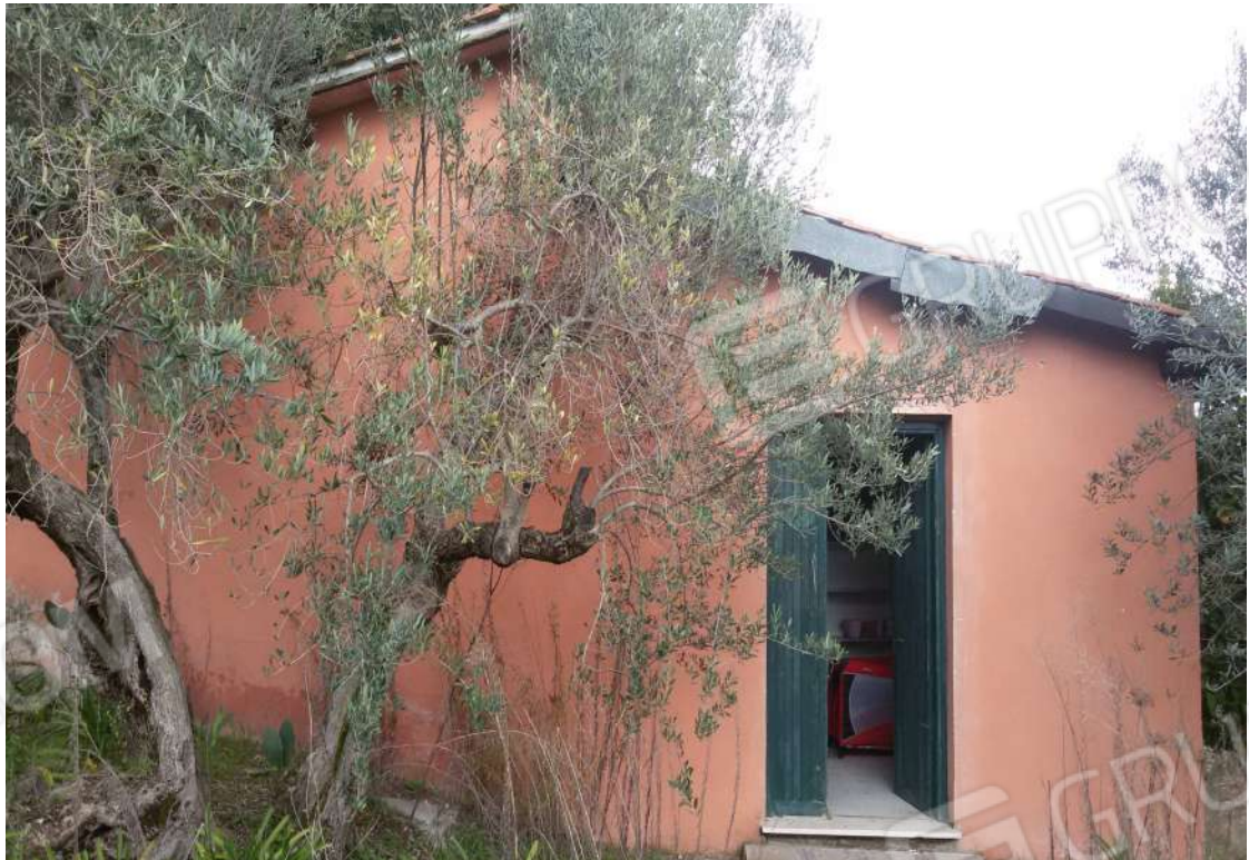
FOTO 2 - FABBRICATO "D" - DISTINTO CON LA PARTICELLA 436
