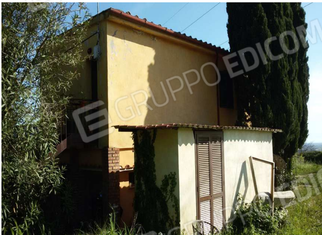
FOTO 5 - FABBRICATO DISTINTO CON LA PARTICELLA 433 – MANUFATTO DA DEMOLIRE SULLA DESTRA
