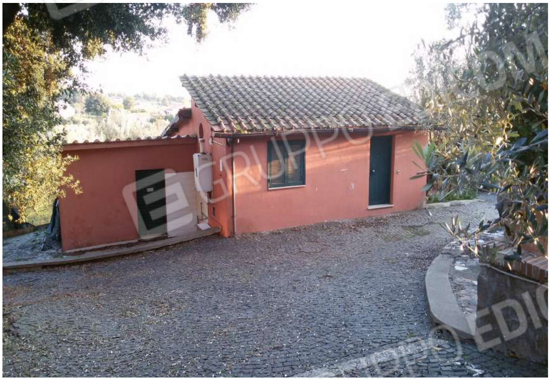
FOTO 1 - FABBRICATO "D" - DISTINTO CON LA PARTICELLA 436 – (AMPLIAMENTO DA DEMOLIRE A SINISTRA DEL FABBRICATO PRINCIPALE)
