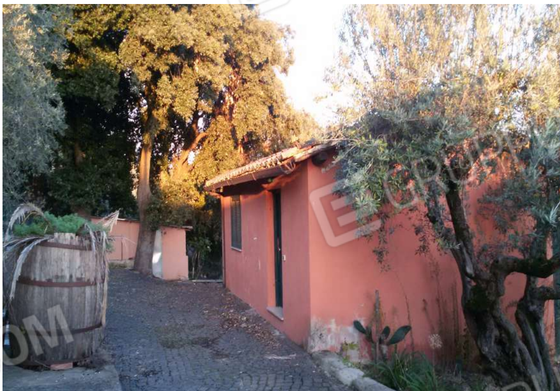
FOTO 2 – MANUFATTO DA DEMOLIRE (IN FONDO A SINISTRA)
