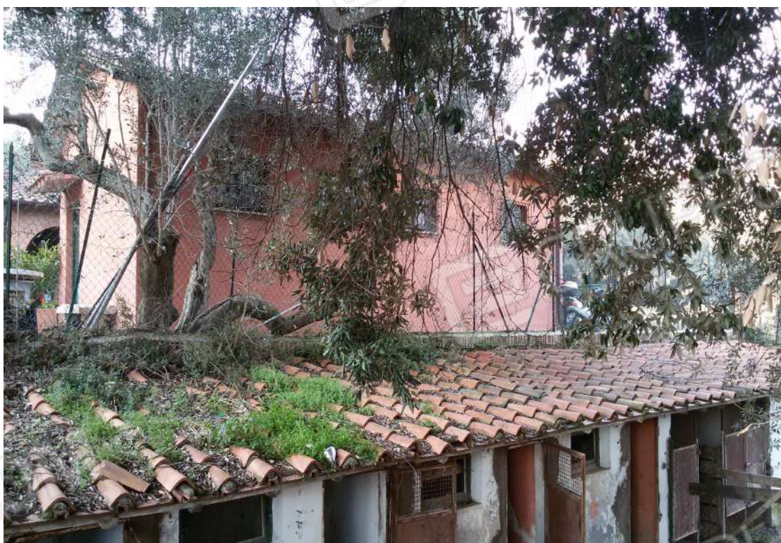
FOTO 6 - FABBRICATO "B" - DISTINTO CON LA PARTICELLA 435 – POLLAIO DA DEMOLIRE
