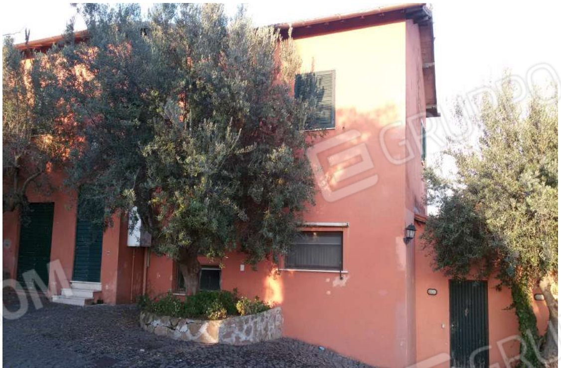
FOTO 2 - FABBRICATO "A" - DISTINTO CON LA PARTICELLA 437
