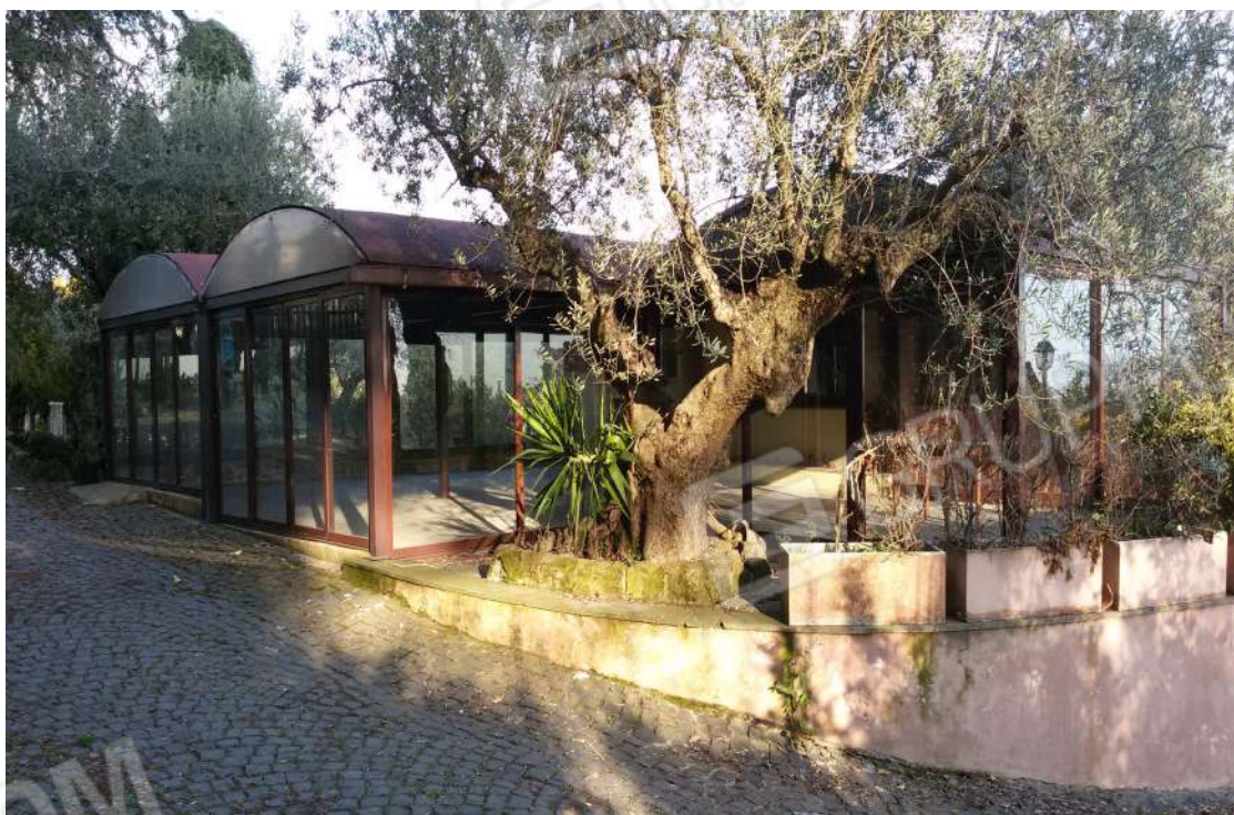
FOTO 6 - FABBRICATO "A" - DISTINTO CON LA PARTICELLA 437 - VERANDA DA DEMOLIRE
