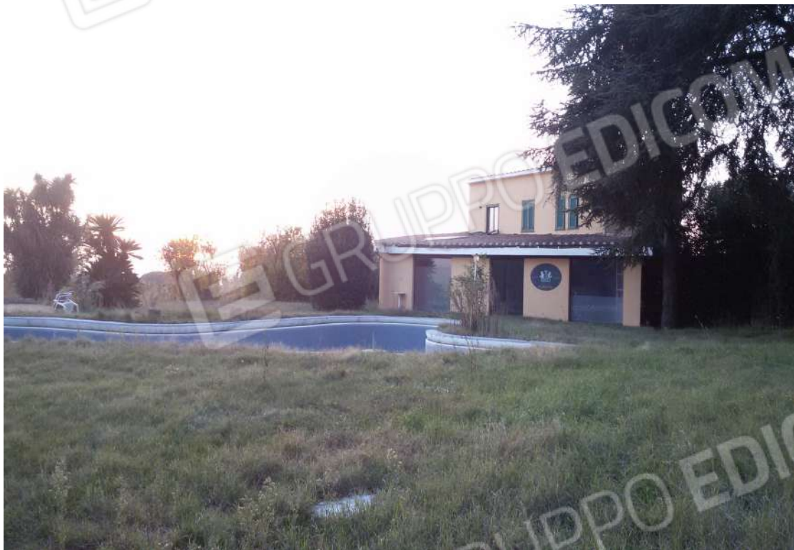
FOTO 1 - FABBRICATO DISTINTO CON LA PARTICELLA 433 – (AMPLIAMENTO DA DEMOLIRE AL PIANO TERRA)
