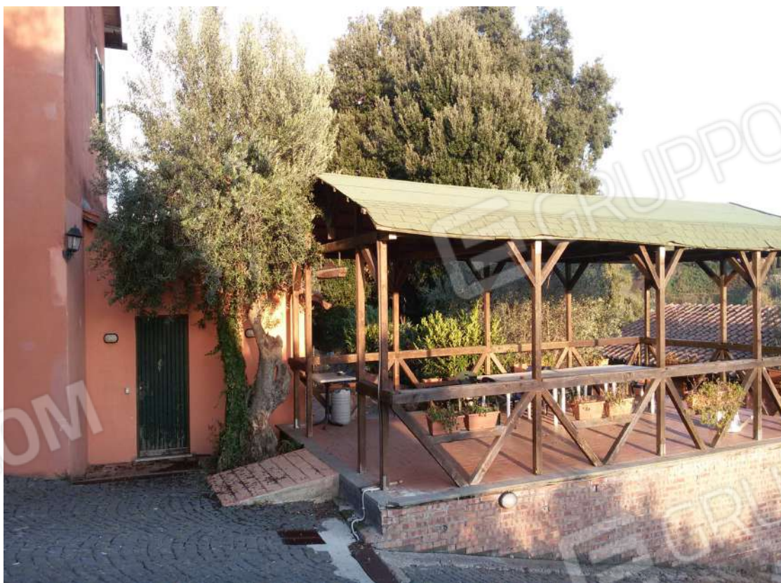
FOTO 8 - FABBRICATO "A" - DISTINTO CON LA PARTICELLA 437 – MANUFATTI DA DEMOLIRE
