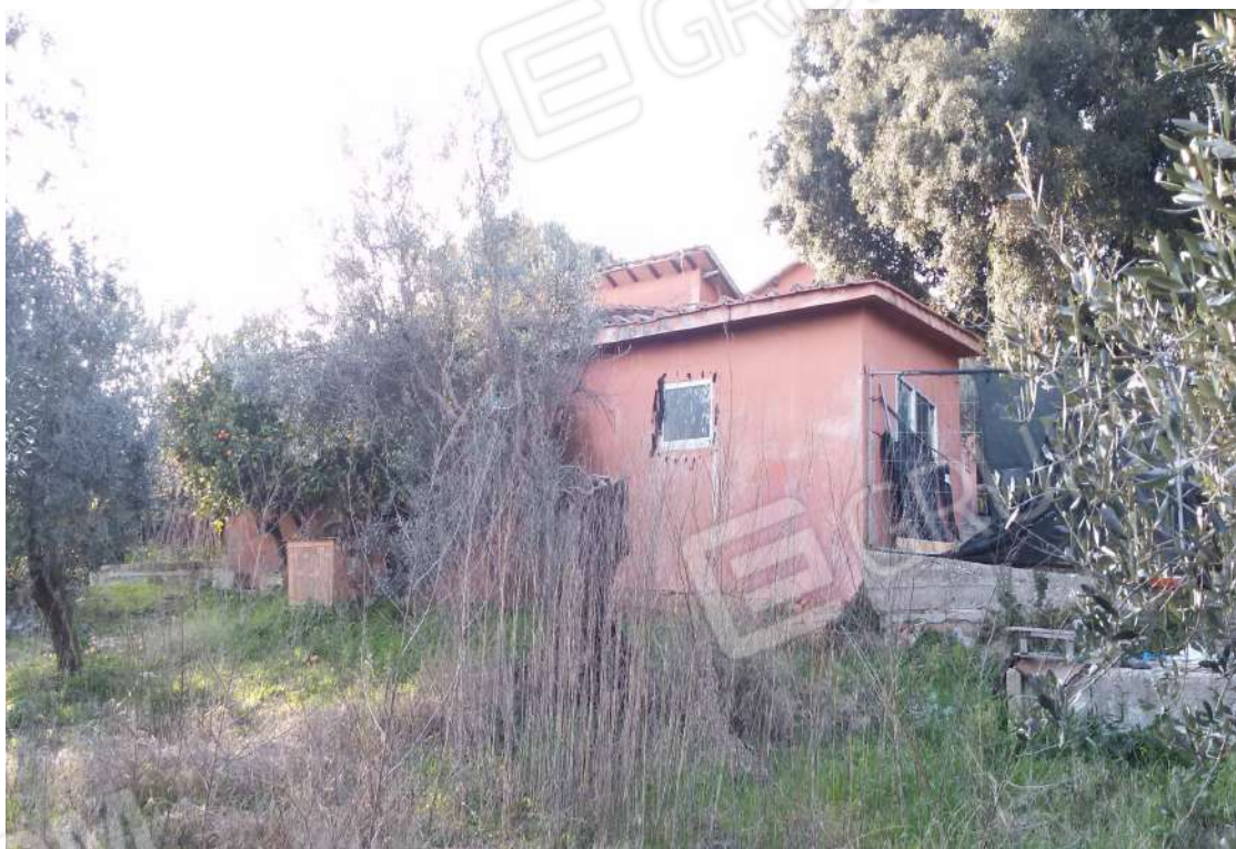
FOTO 4 - FABBRICATO "D" - DISTINTO CON LA PARTICELLA 436 - (AMPLIAMENTO DA DEMOLIRE A DESTRA DEL FABBRICATO PRINCIPALE)
