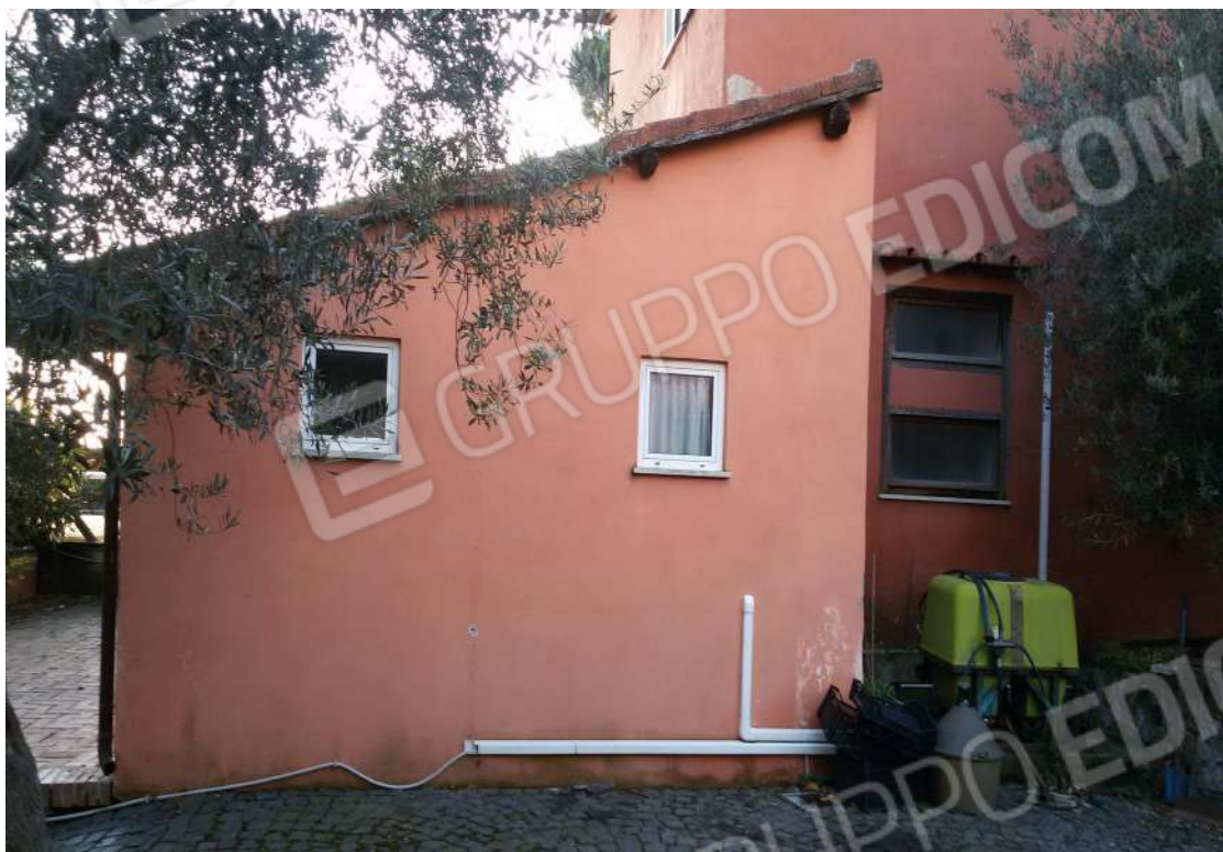
FOTO 7 - FABBRICATO "A" - DISTINTO CON LA PARTICELLA 437 – MANUFATTO DA DEMOLIRE
