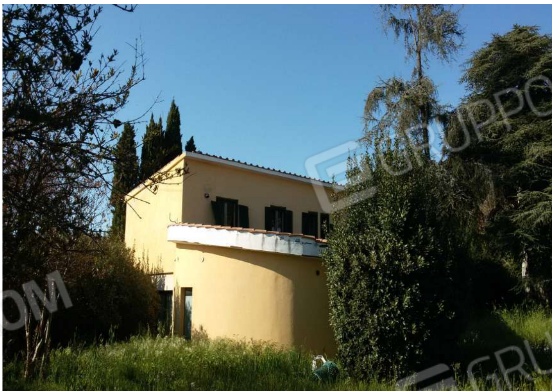
FOTO 2 - FABBRICATO DISTINTO CON LA PARTICELLA 433 – (AMPLIAMENTO DA DEMOLIRE AL PIANO TERRA)
