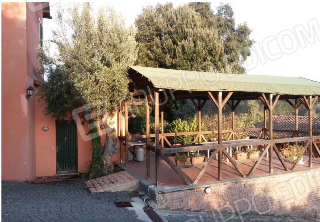
FOTO 1 – PORTICO IN LEGNO DA DEMOLIRE
